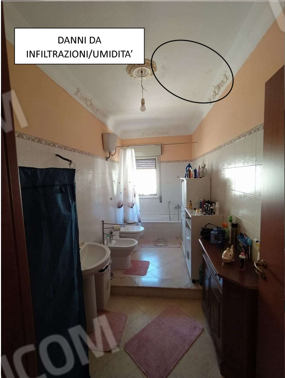
DANNI DA INFILTRAZIONI/UMIDITA'
