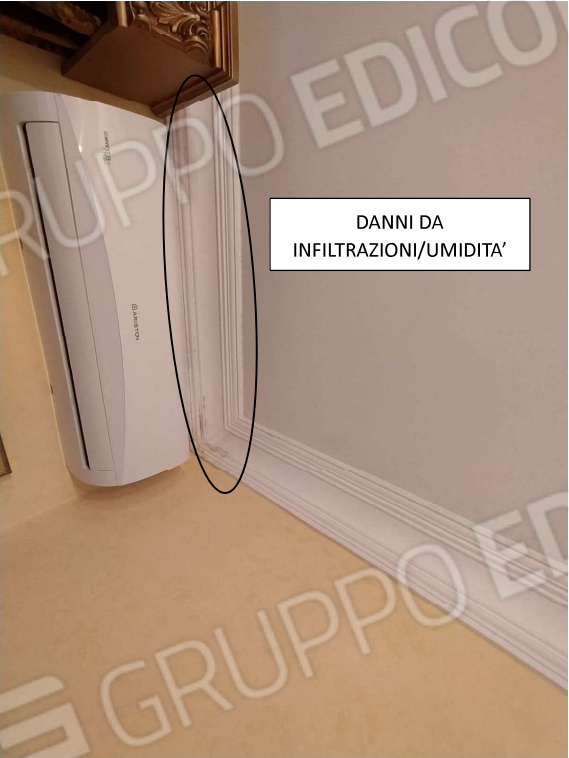
DANNI DA INFILTRAZIONI/UMIDITA'
