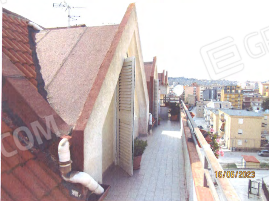
FOTO 19 Veduta dal balcone lato Nord
