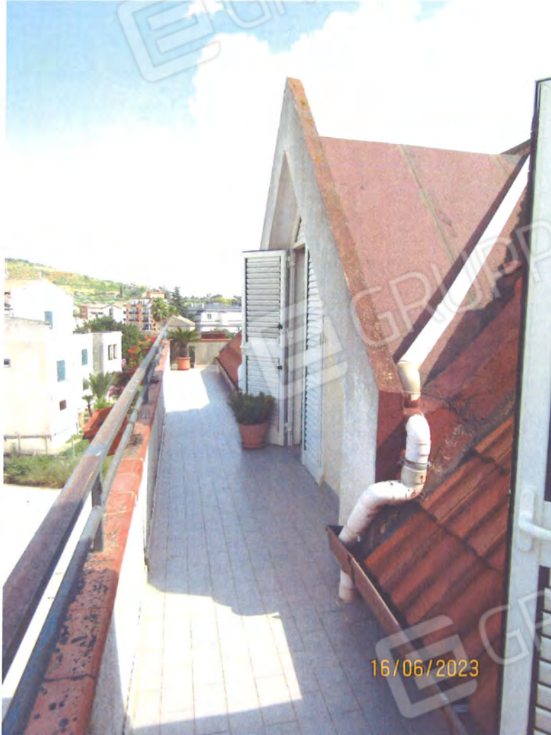
FOTO 20 Veduta dal balcone lato Nord
