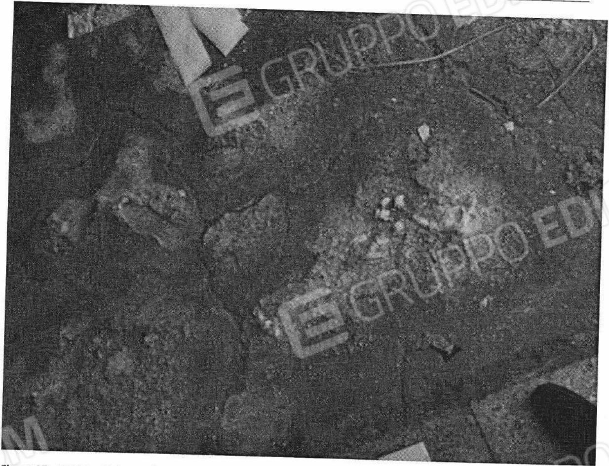
Figura 17 – Pavimento in pessime condizioni con efflorescenze
