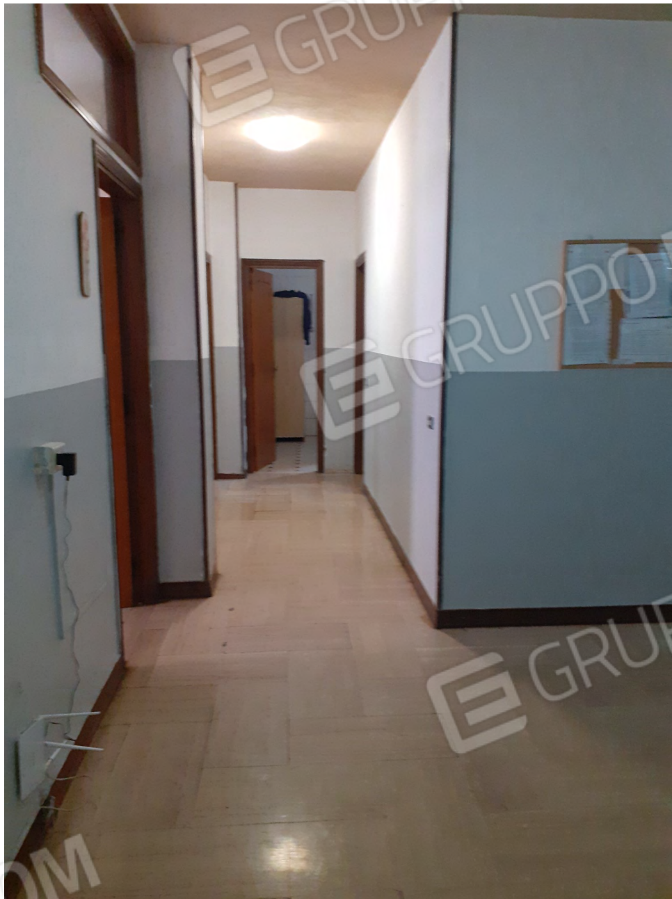
FOTO 5: Veduta dal corridoio
