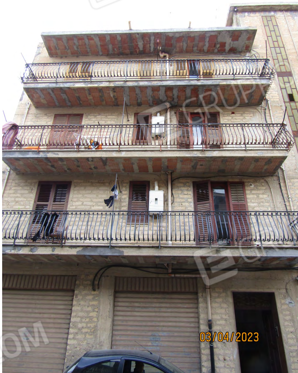
FOTO 1 : Veduta del prospetto del fabbricato su Via Don Luigi Sturzo, con ingresso alla scala condominiale dell'appartamento pignorato a piano terzo
