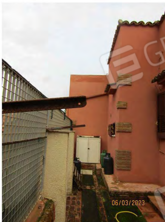
FOTO 10 – VEDUTA DALL'ESTERNO LATO OVEST
