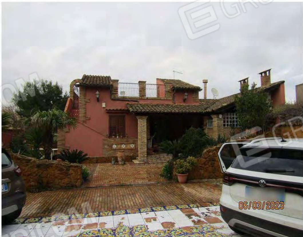
FOTO 17 – VEDUTA DALL'ESTERNO LATO NORD
