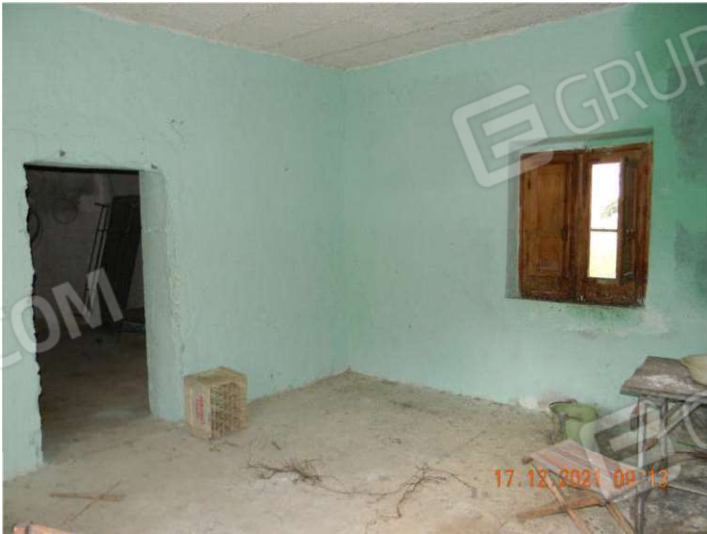
FOTO 14 - Vano di ingresso al primo piano (piano terra a monte).
