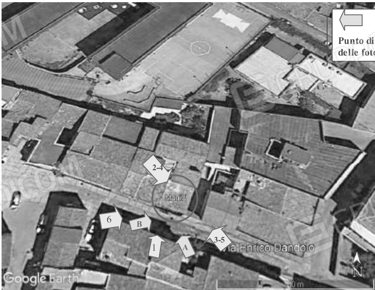
Contesto urbanistico nelle vicinanze del Fabbricato Collabente di via Dandolo a Canicattì
