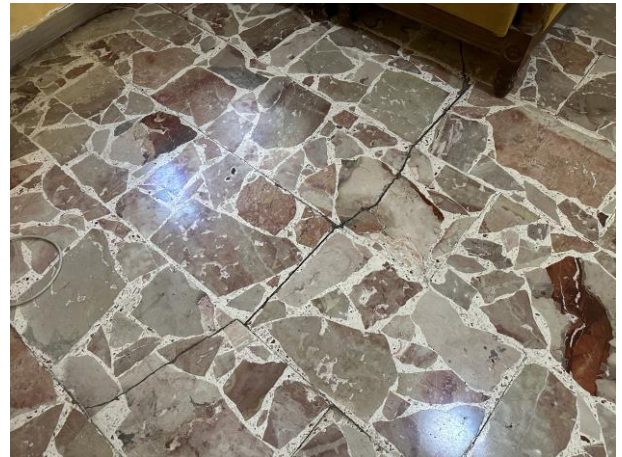
Lesione pavimento piano primo
