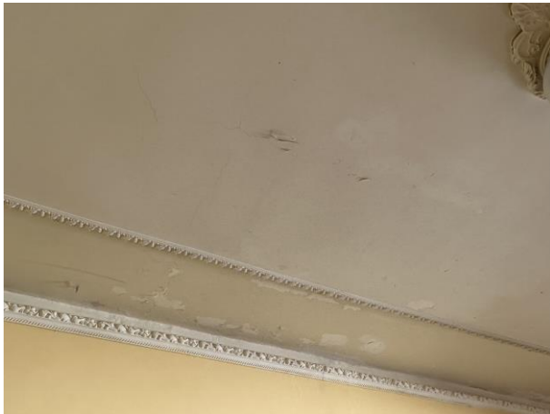
Infiltrazioni piano primo
