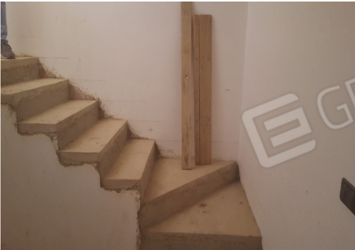
Foto n.19: Scala di accesso al piano 1°
