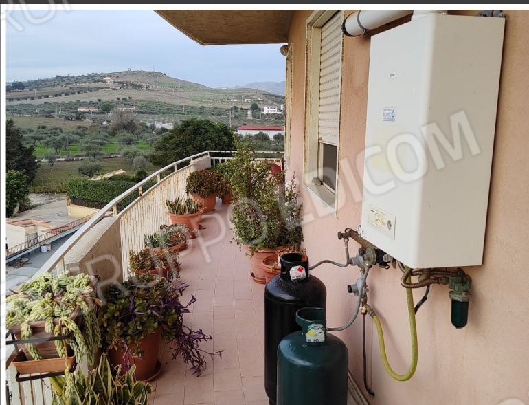
Foto n. 2 – balcone su facciata anteriore
