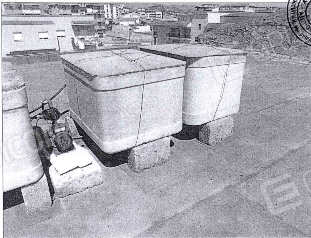
Foto n° 13 Serbatoi in eternit da eliminare come rifiuti speciali.
