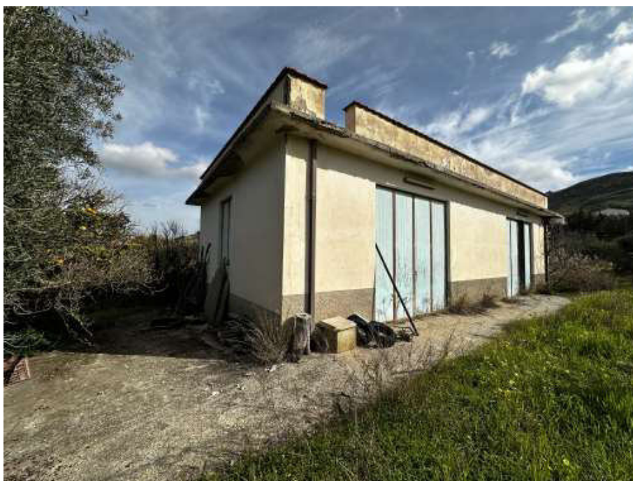
Immagine n.1 . Locale deposito
