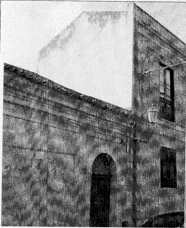
Foto 3 - Veduta del prospetto est dalla via Dante
