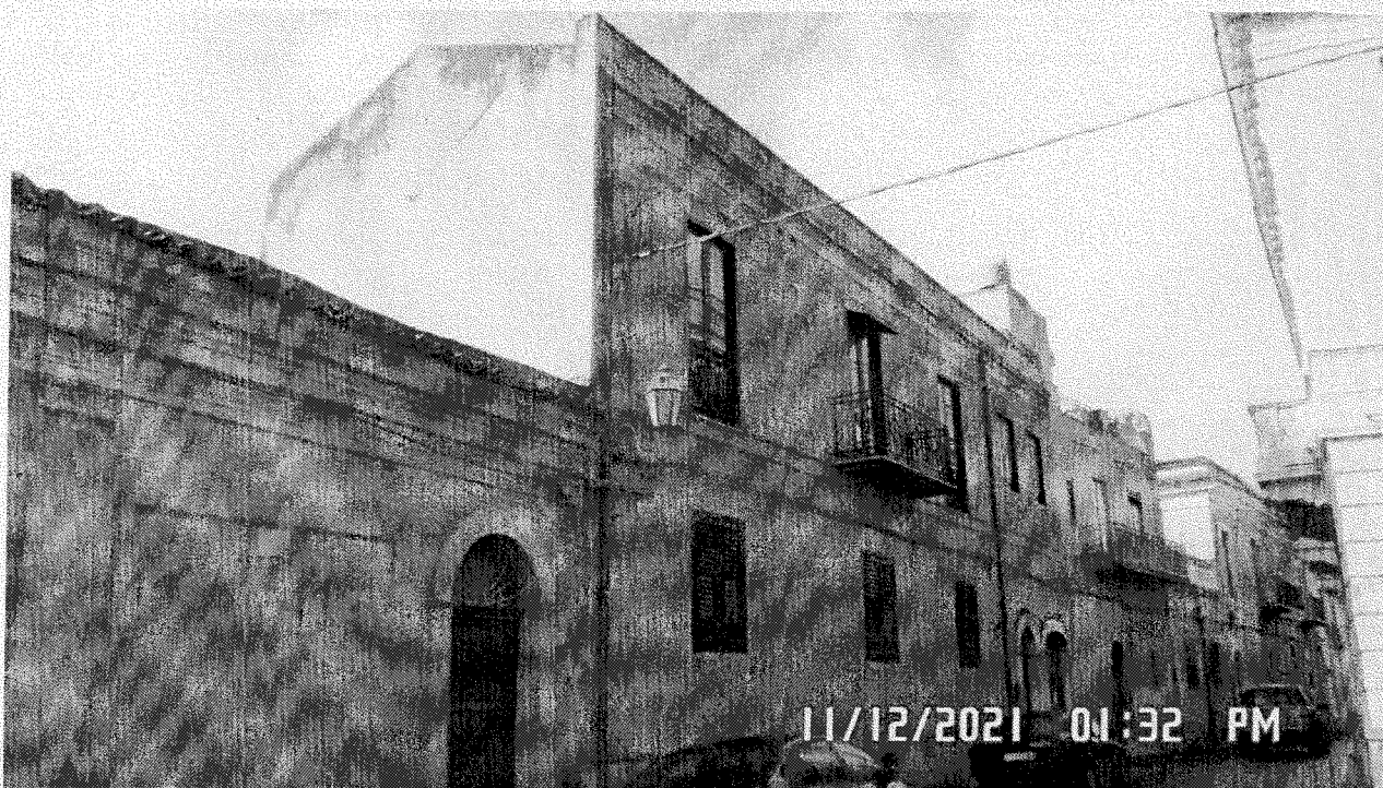
Foto 1 – Veduta del prospetto nord sulla via Dante n. 33
