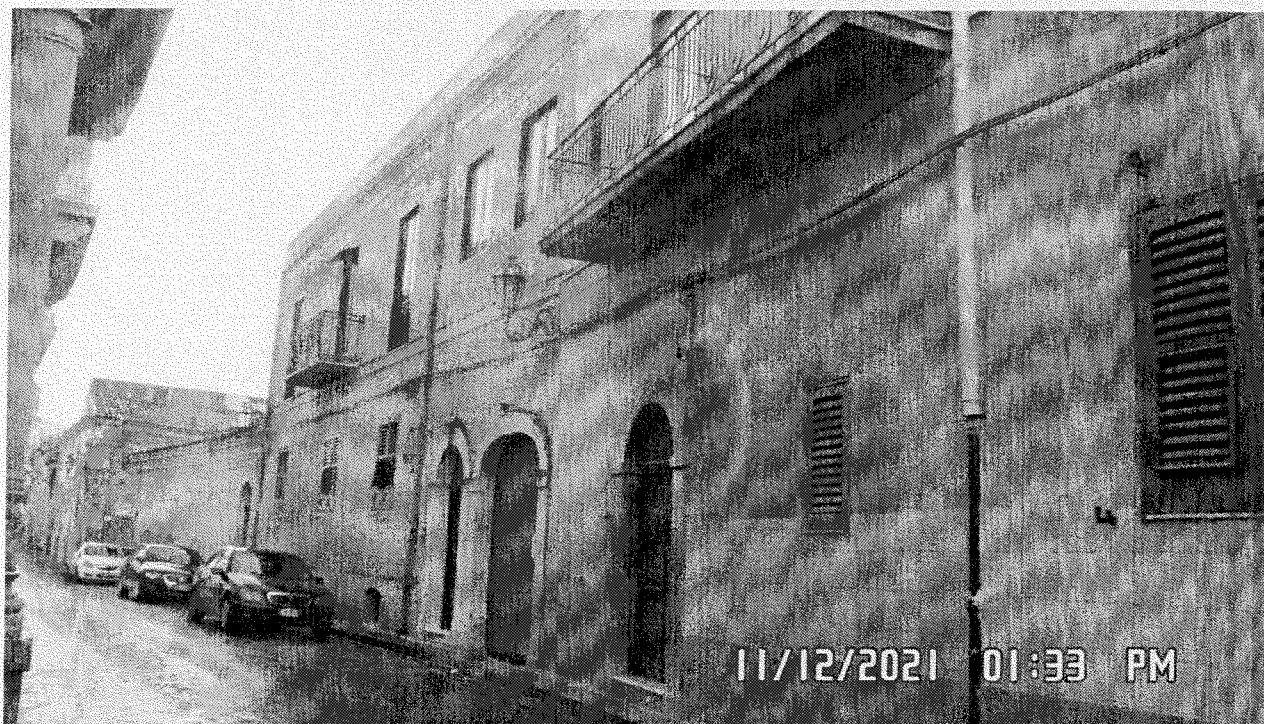
Foto 2 – Veduta del prospetto nord sulla via Dante n. 33
