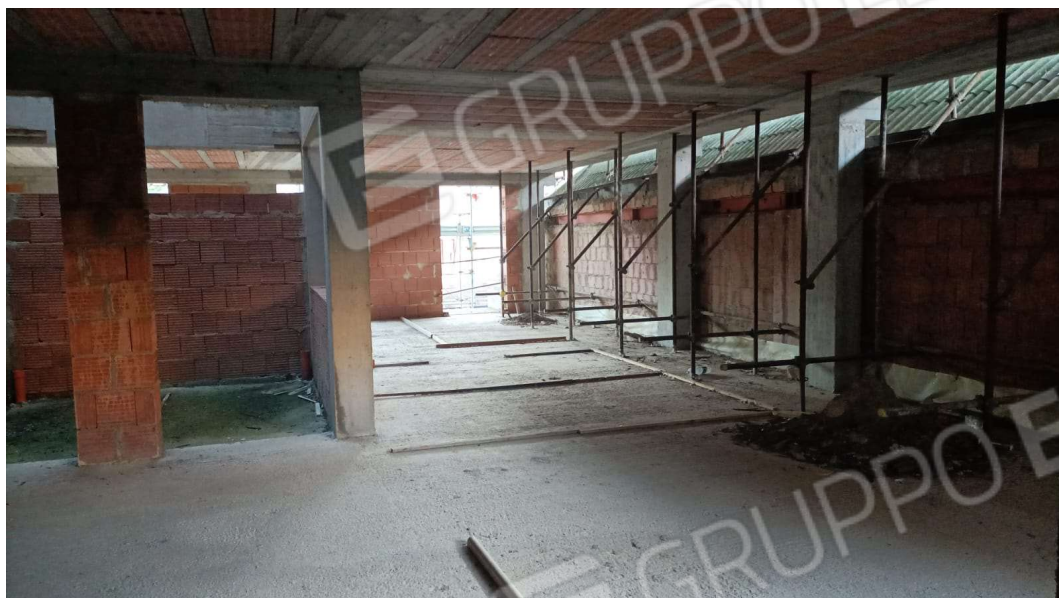
VISTA INTERNA LOTTO N. 6
