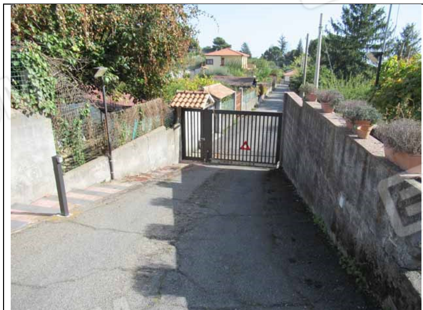
foto n° 27: Vista dell'ingresso dall'interno
