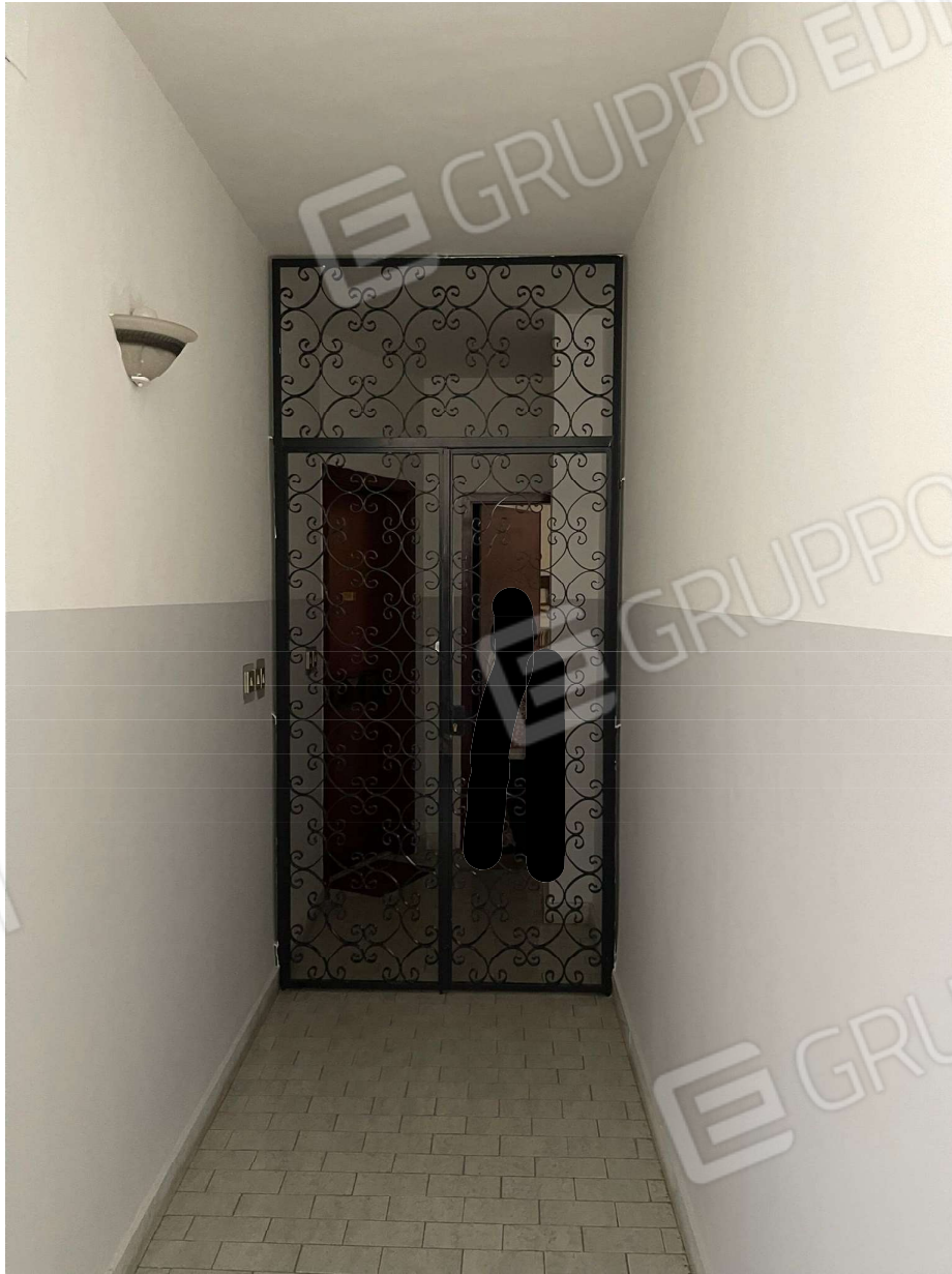
Foto 3 - Vista del pianerottolo d'ingresso4
