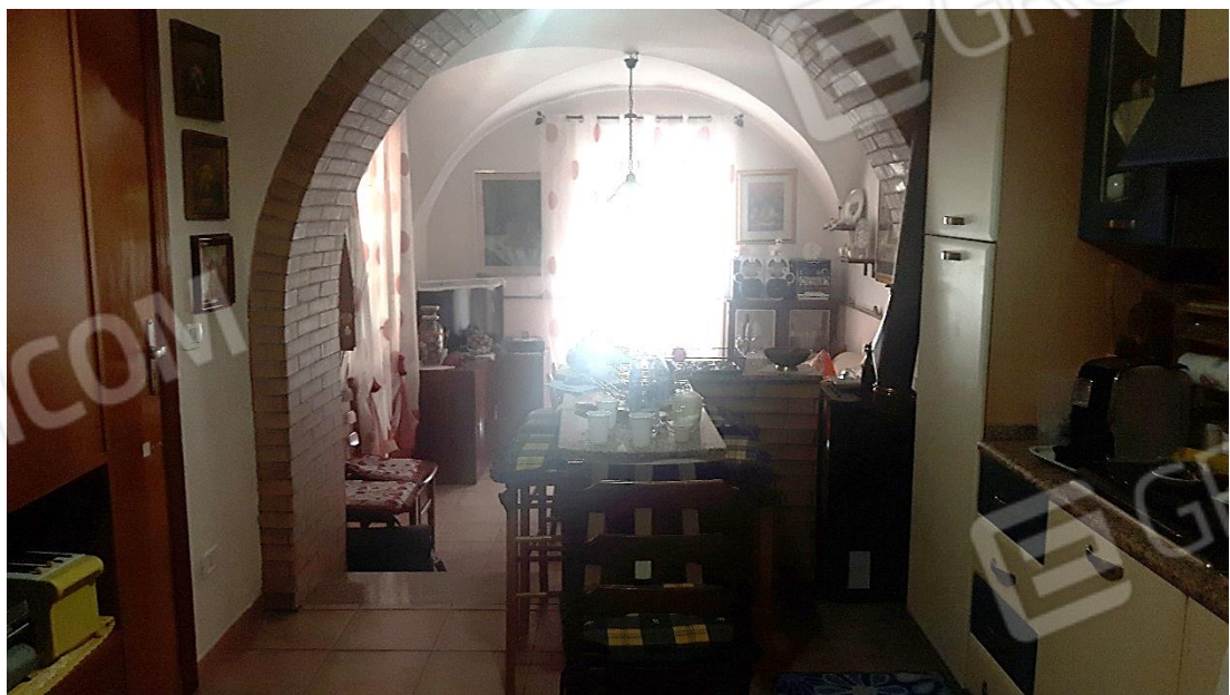
Foto 5 – Vista della Sala da Pranzo dalla Cucina e dell'apertura da regolarizzare (arco)
