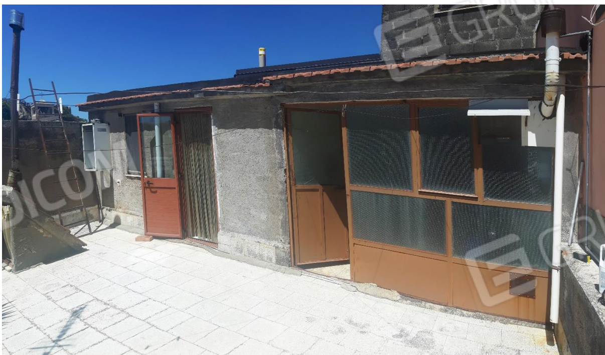
Foto 29 – Vista del piano secondo dalla terrazza di copertura.
