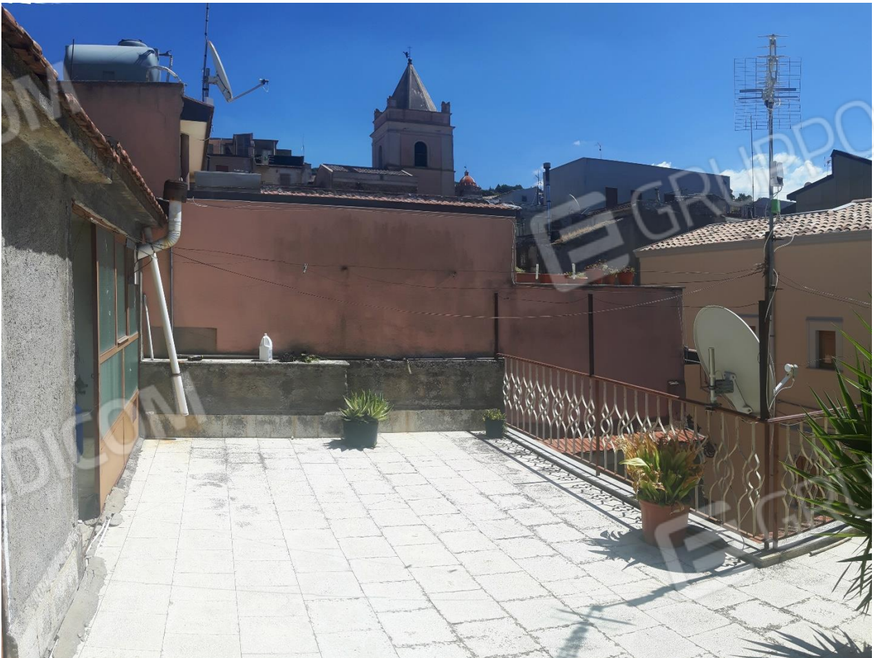
Foto 33 – Terrazza di copertura
