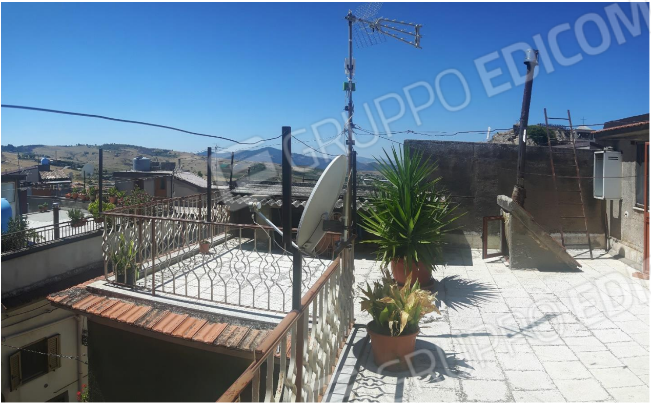
Foto 32 – Terrazza di copertura
