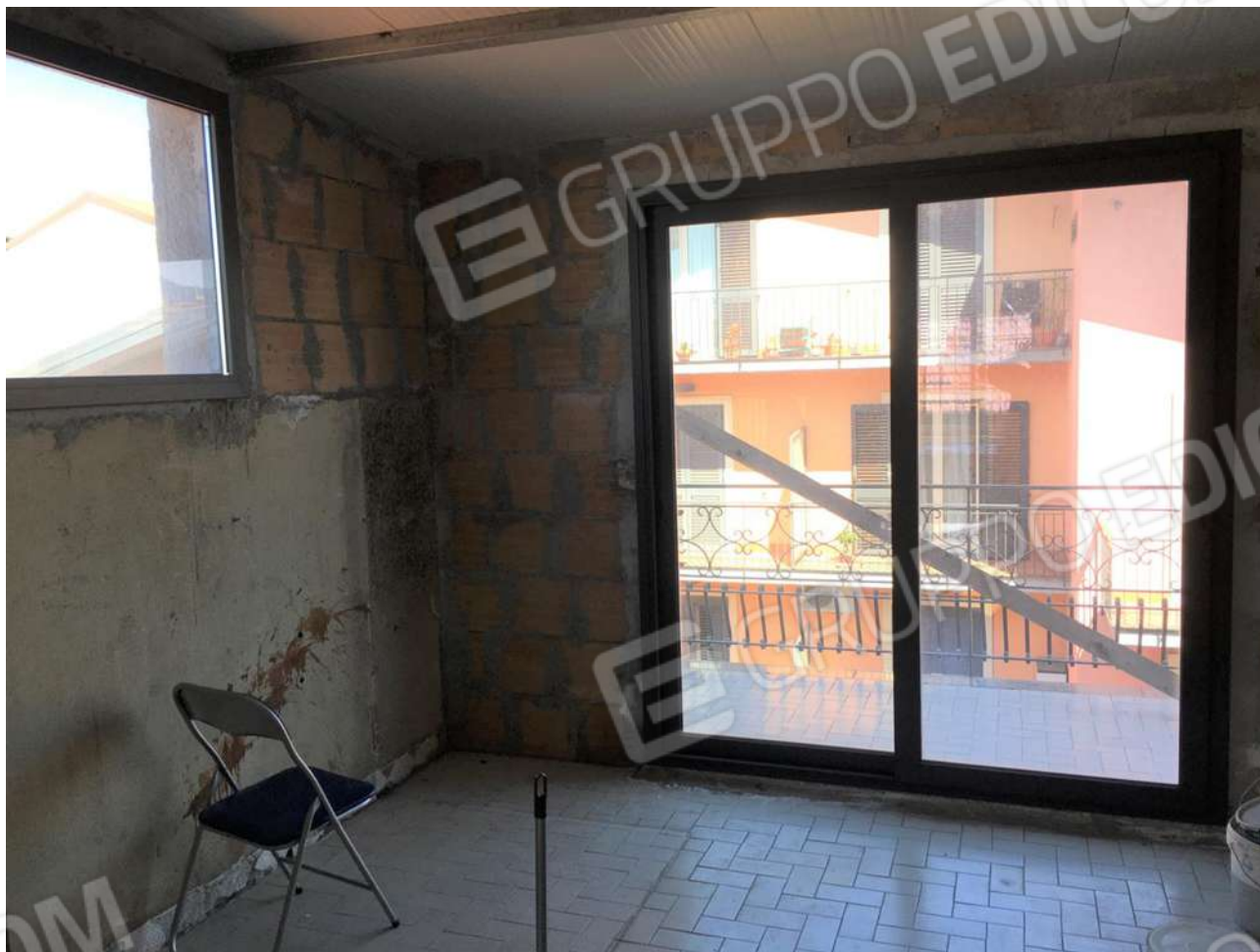
FO-21 vano realizzato in ampliamento su terrazzo appartamento piano secondo
