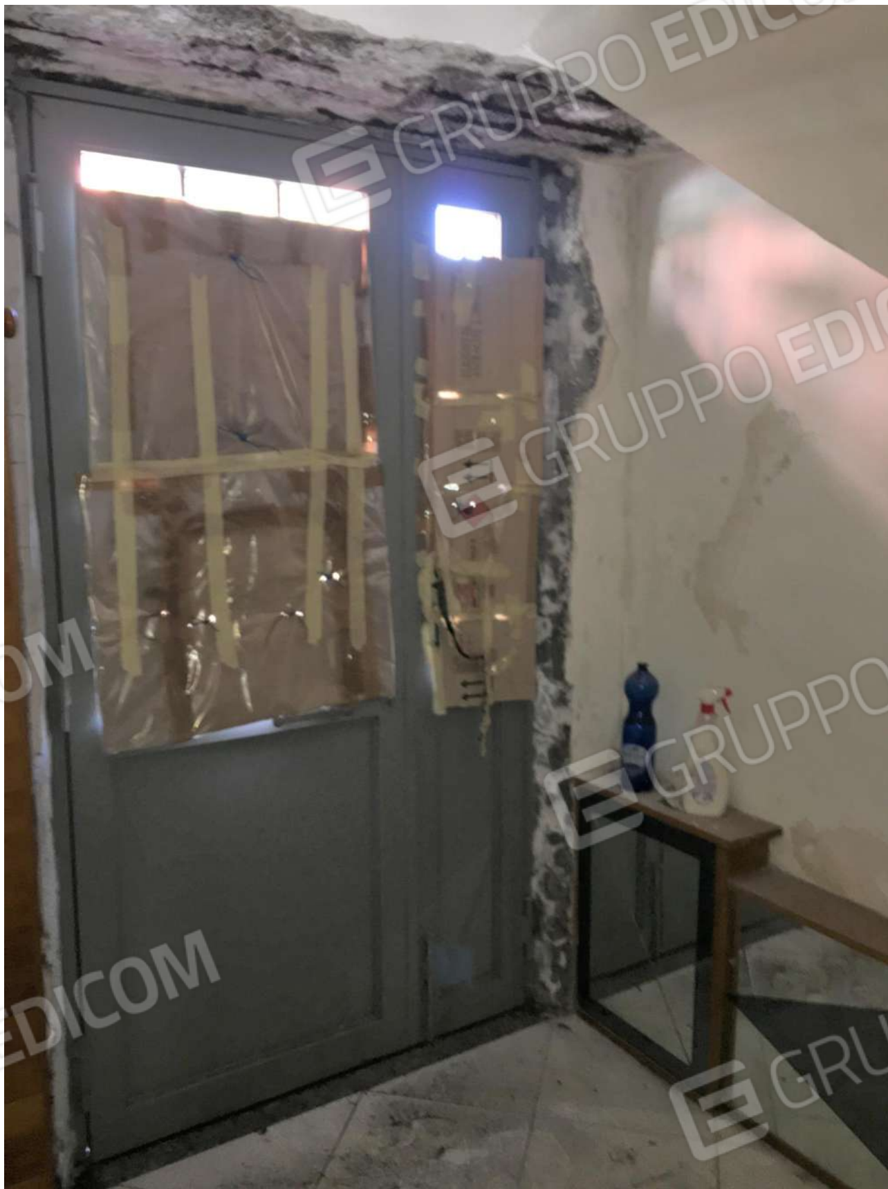
FO-3 vano scala appartamento piano terra
