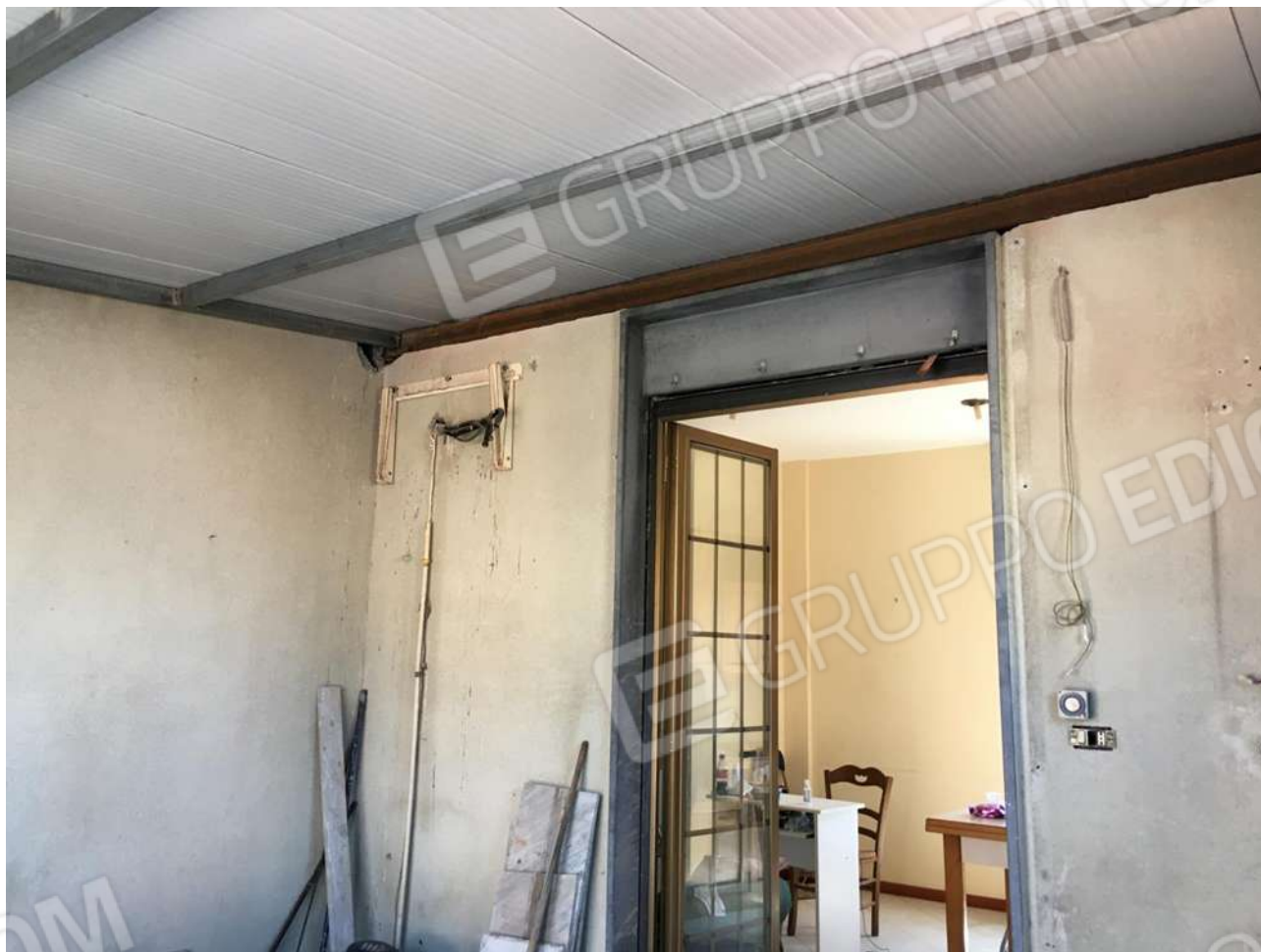
FO-22 vano realizzato in ampliamento su terrazzo appartamento piano secondo
