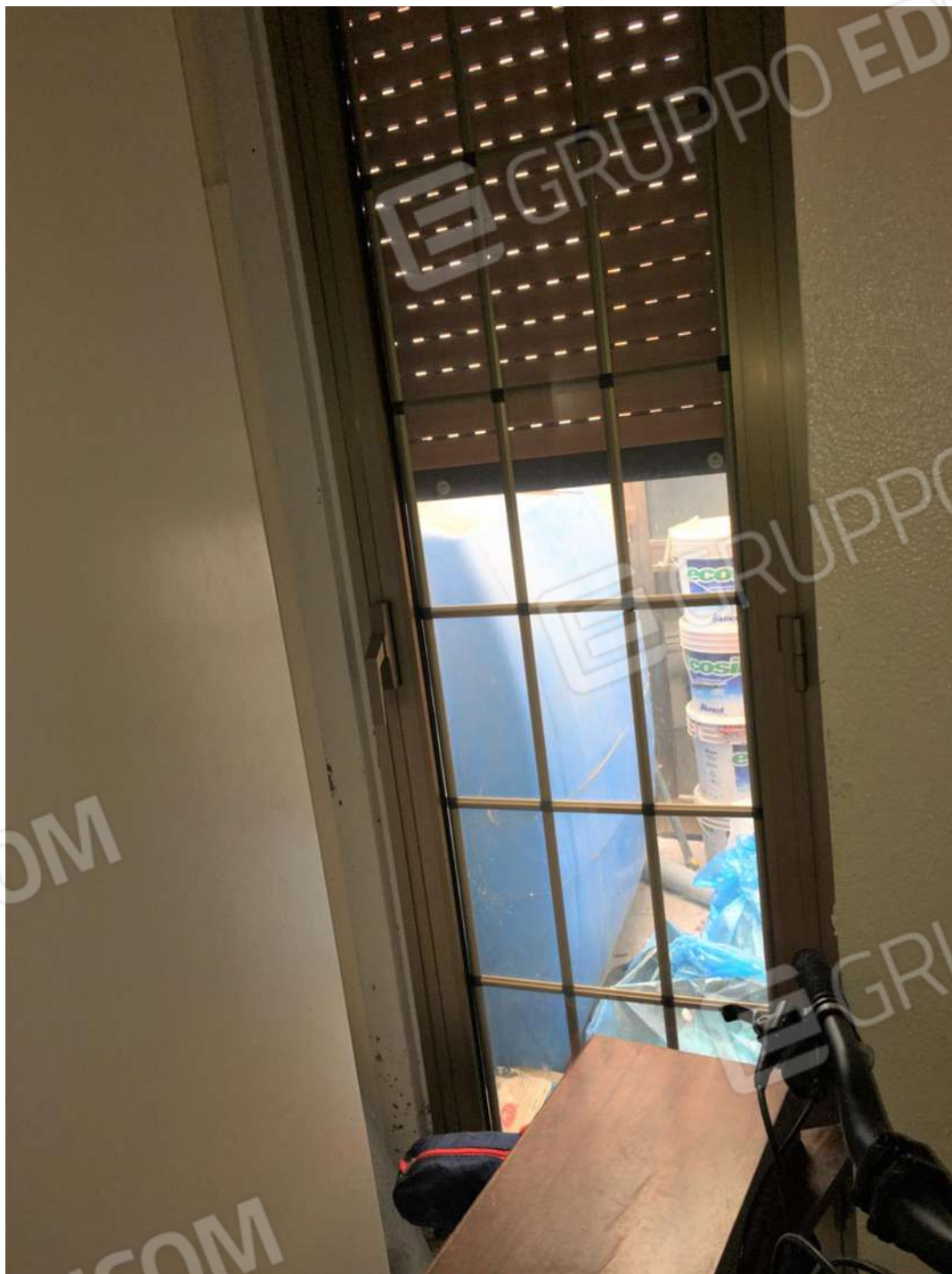
FO-8 ripostiglio appartamento piano terra
