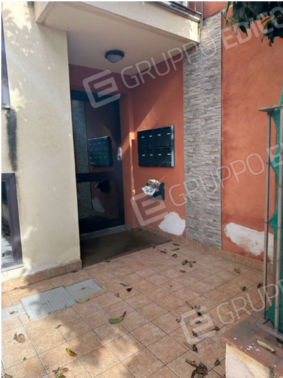
FOTO 8 _ingresso all'edificio comune
