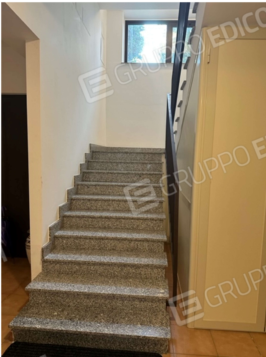
FOTO 7_vano scala comune
