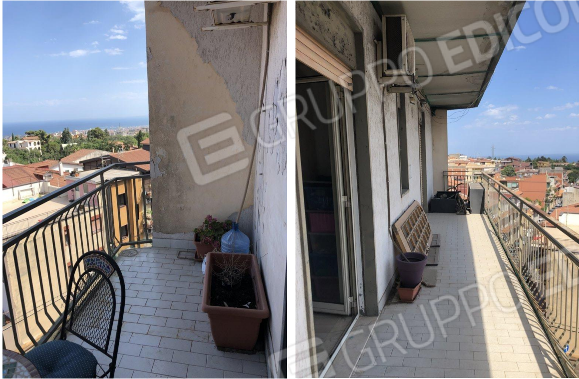
Foto nn 14-15 Vista dei balconi.
