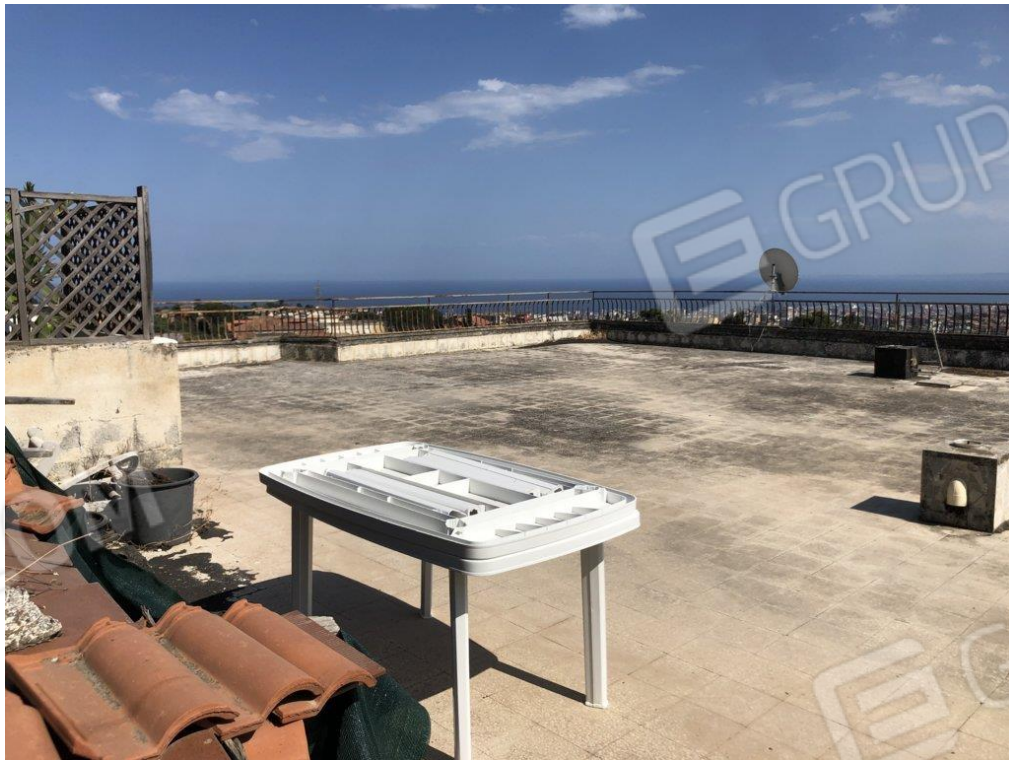
Foto n.16 Vista del lastrico solare.
