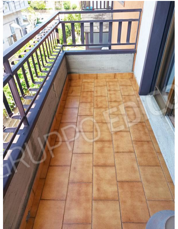
Foto n. 14 – Immobile I1: Balcone 2.
