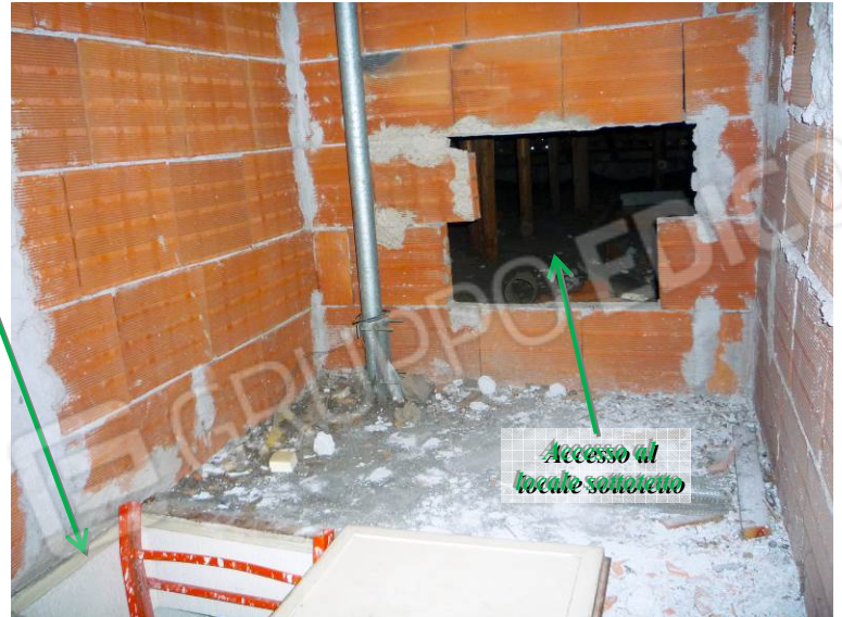
Foto n. 18 – Disimpegno comune, tramite il quale è possibile accedere al locale sottotetto.
