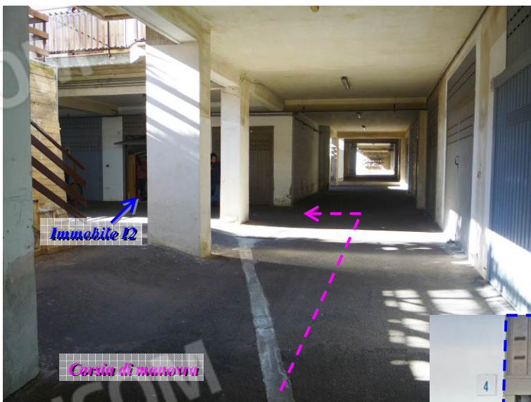
Foto n. 23 – Immobile I2: Corsia di manovra che, dalla rampa, conduce al garage.
