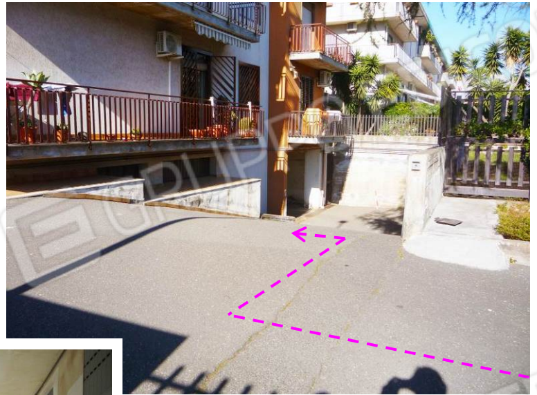
Foto n. 22 – Immobile I2: Rampa (che si diparte dall'ingresso carrabile al civico n. 13) che dà accesso alla corsia di manovra che conduce al garage.
