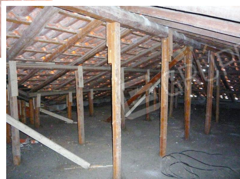
Foto n. 20 – Veduta sud-ovest del locale sottotetto.
