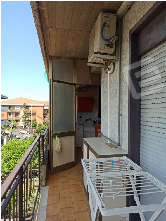
Foto n. 13 – Immobile I1: Balcone 1.
