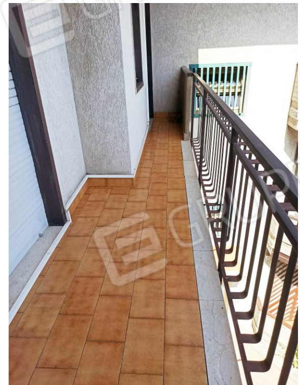
Foto n. 16 – Immobile I1: Balcone 3 (veduta est).
