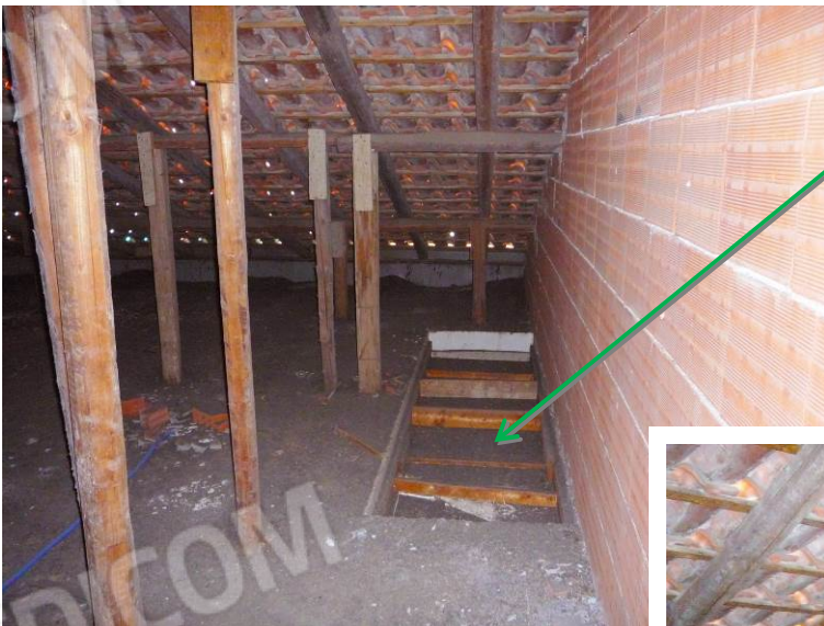
Foto n. 19 – Scorcio nord del locale sottotetto: si noti la presenza di una predisposizione di collegamento (foro per vano scala interno) con la zona soggiorno del sottostante bene I1.
