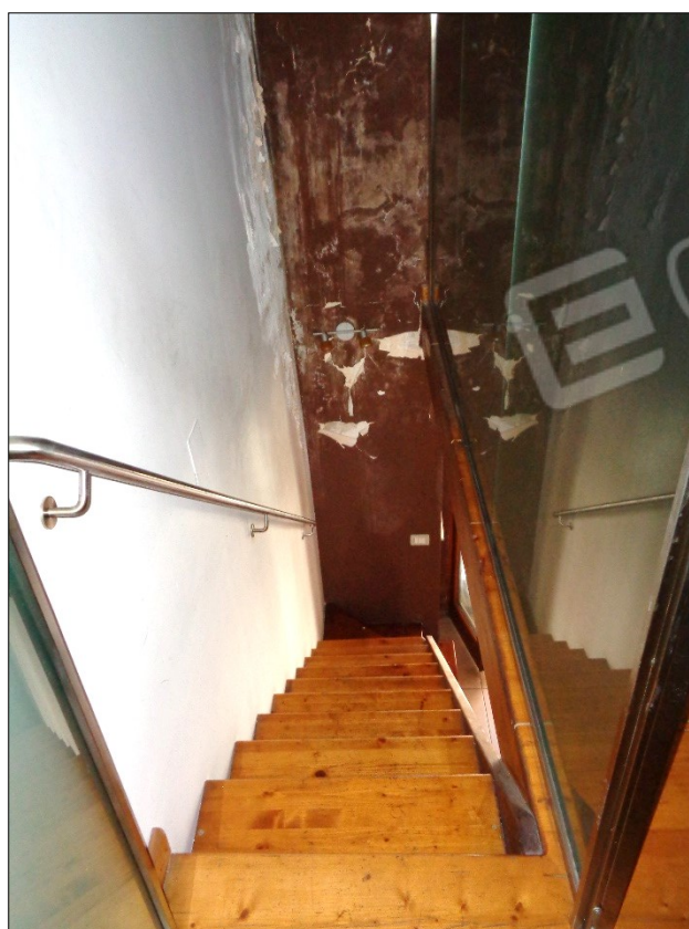
FOTO N° 14 – SCALA PER L'ACCESSO AL SOPPALCO
