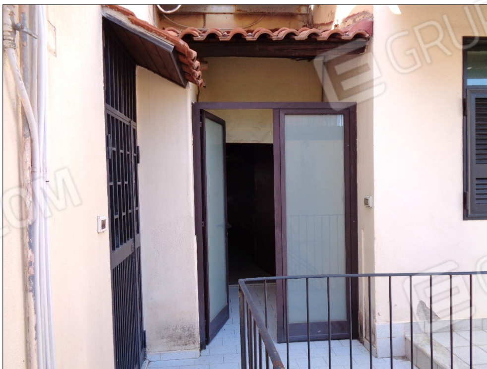
FOTO N° 4 - PIANEROTTOLO CONDOMINIALE AL PIANO PRIMO
