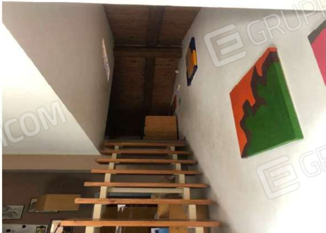
Foto n° 18 — Scala realizzata per raggiungere il sottotetto. —
