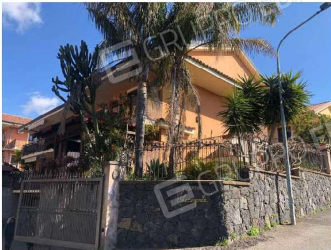
Foto n° 25 – Ingresso al garage al piano S1 del civico 17 della Via Dott. S. Valenti. –
