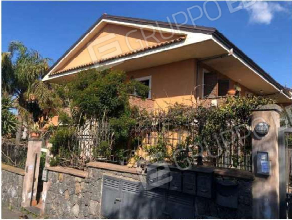
Foto n° 1 – Prospetto dell'immobile oggetto di stima in San Pietro Clarenza (CT). –
