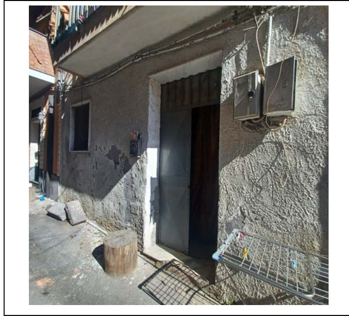
Foto del portone di ingresso
