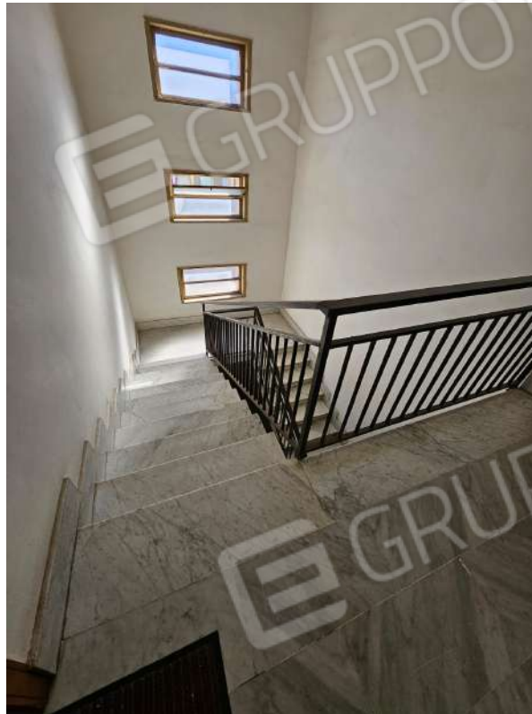
Foto n° 3 – Vano scala di accesso all'unità immobiliare. –
