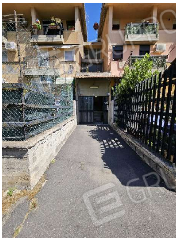
Foto n° 1 – Ingresso esterno dal vano Scala all'immobile oggetto di stima in Catania, Viale Bummacaro n. 6/D –
