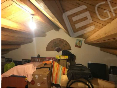
-Foto 13 (particolare 2 sottotetto)
