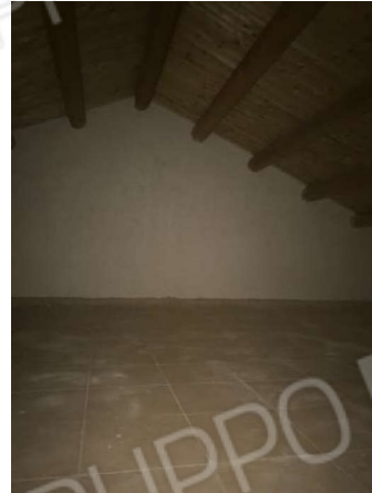
-Foto 14 (particolare 2 sottotetto)
