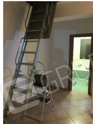
-Foto 8 (disimpegno piano secondo)
