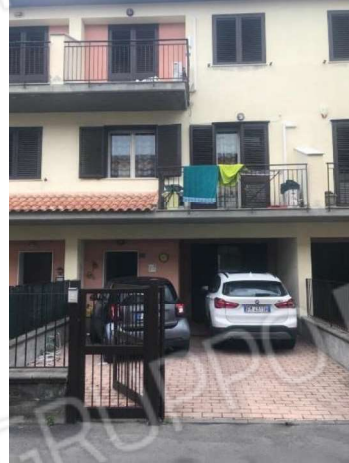
-Foto 14 (prospetto esterno)
