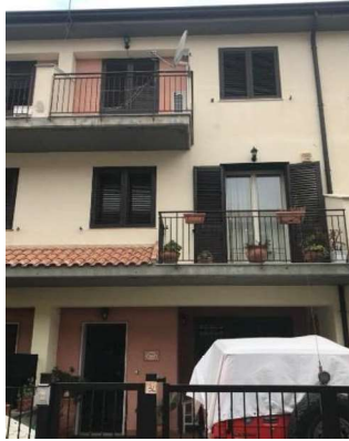
-Foto 13 (prospetto esterno)
