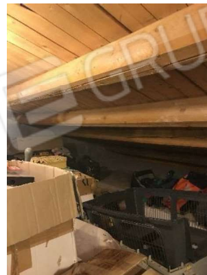
-Foto 12 (particolare sottotetto)
