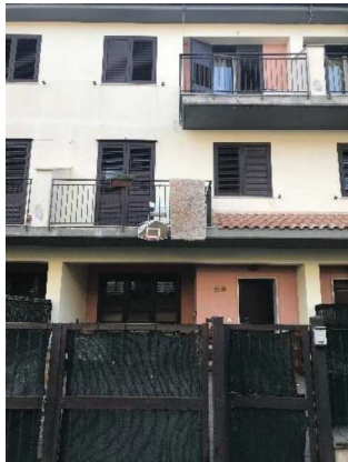
-Foto 15 (prospetto esterno)
