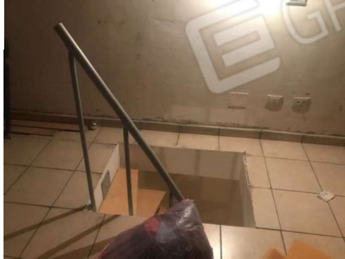
-Foto 13 (particolare 2 sottotetto)
