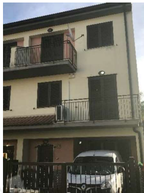
-Foto 11 (prospetto esterno)
