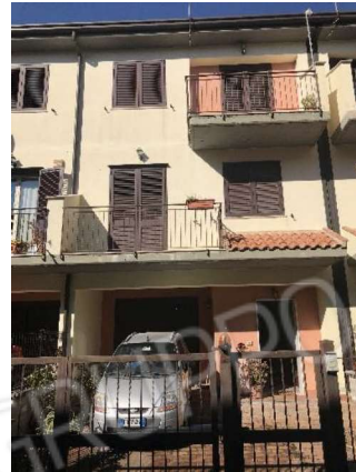
-Foto 14 (prospetto esterno)
