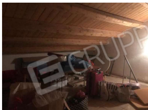
-Foto 12 (particolare 1 sottotetto)
