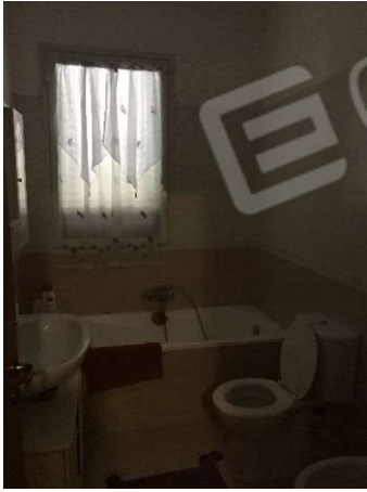
-Foto 5 (bagno piano secondo)
