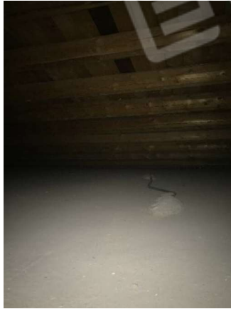
-Foto 13 (particolare sottotetto)
