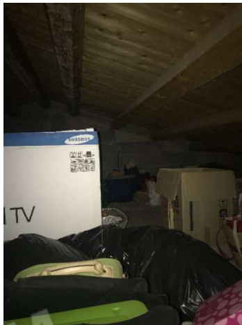
-Foto 11 (particolare sottotetto)
