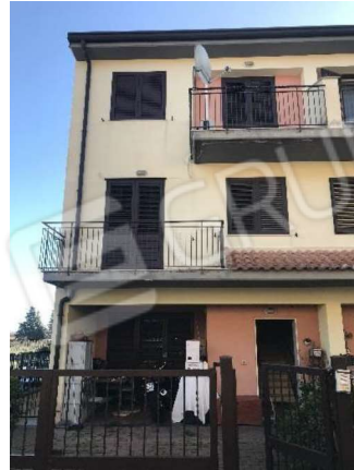
-Foto 12 (prospetto esterno)
