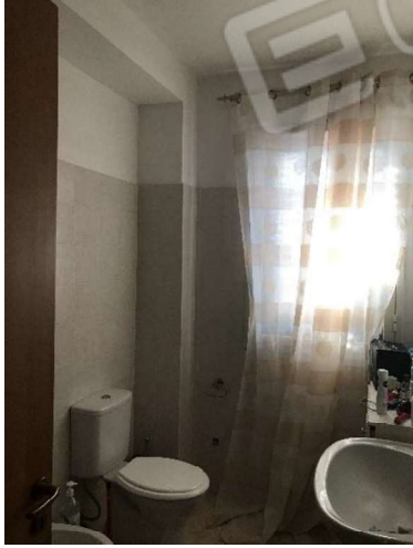
-Foto 1 (bagno piano primo)
