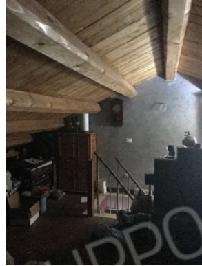
-Foto 10 (particolare sottotetto)
