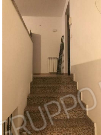
-Foto 2 (particolare scala piano primo)
