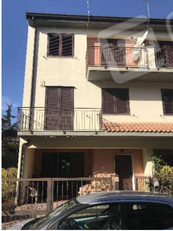
-Foto 13 (prospetto esterno)
