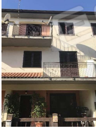
-Foto 13 (prospetto esterno)
