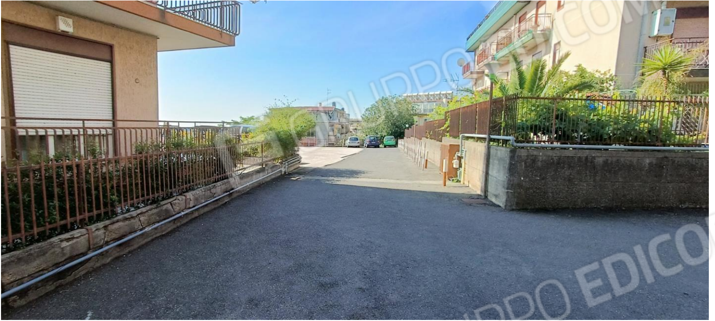
Figura 5: Vialetto interno e accesso ai posti auto scoperti
