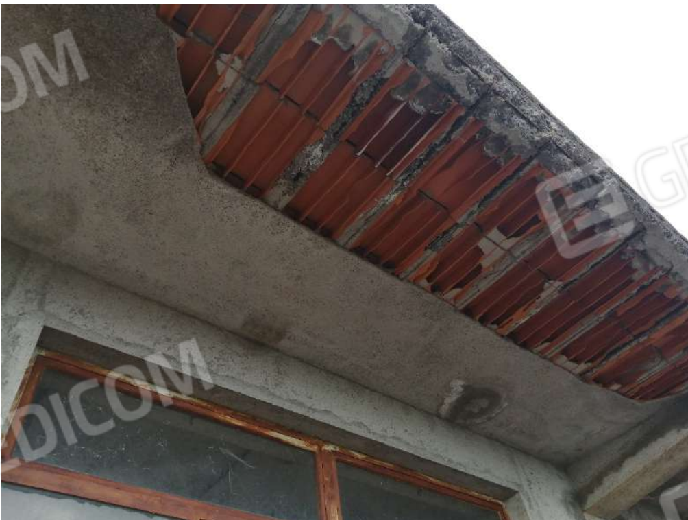
FO-52 PART. 159 FOGLIO 31 RIF. B – ESTERNO
