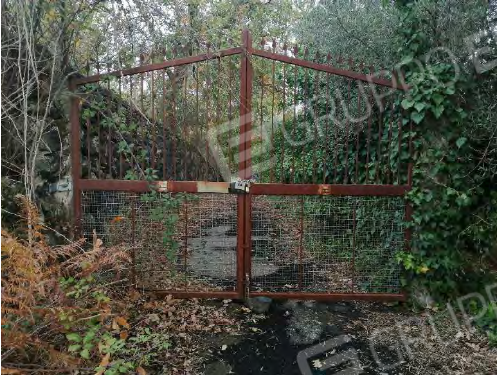
FO-1 INGRESSO AL FONDO POSTO NELL'ESTREMA PORZIONE NORD PART. 155 FOGLIO 31
