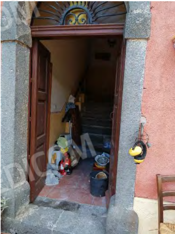
FO-70 PART. 159 FOGLIO 31 RIF. C – ESTERNO LATO OVEST – INGRESSO AL CORPO DI SCALE CHE CONDUCE AL PIANO PRIMO
