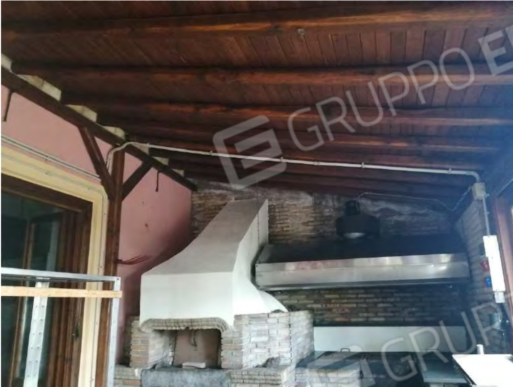
FO-89 PART. 159 FOGLIO 31 RIF. C – INTERNO – PIANO SECONDO - SALA RISTORAZIONE TERRAZZA
