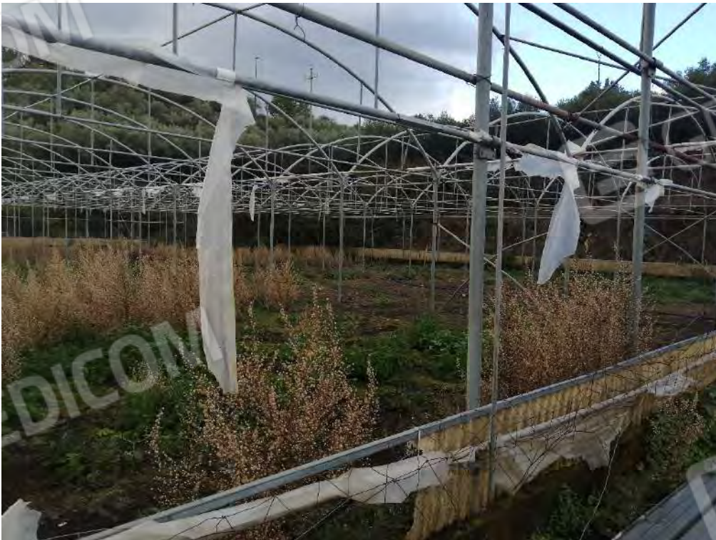
FO-44 STRUTTURE EX SERRE PRESENTI SU PORZIONE PARTICELLA 485 FOGLIO 34
