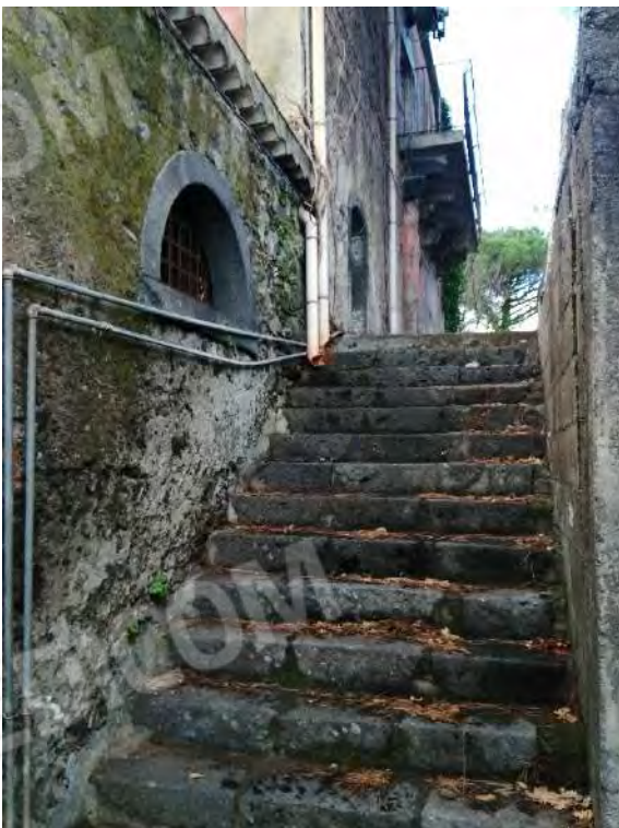
FO-74 PART. 159 FOGLIO 31 RIF. C – ESTERNO CANTINA -PIANO TERRA LATO SUD/EST
