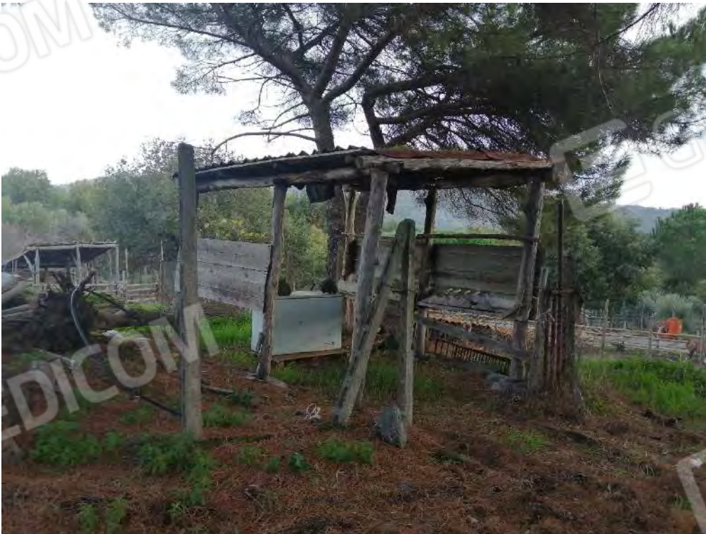
FO-46 STRUTTURE PRECARIE PRESENTI SU PARTICELLA 485 FOGLIO 34
