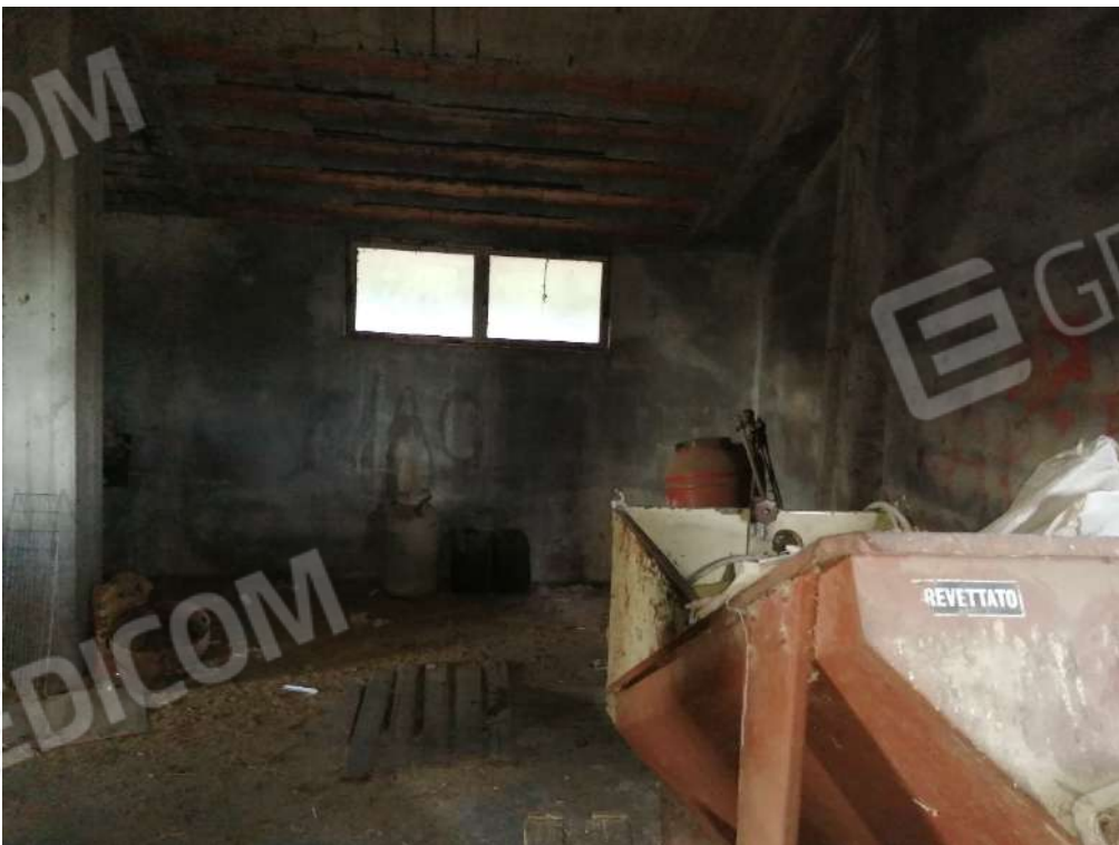
FO-40 CORPO DI FABBRICA PART. 486 – A – PIANO PRIMO INTERNO
