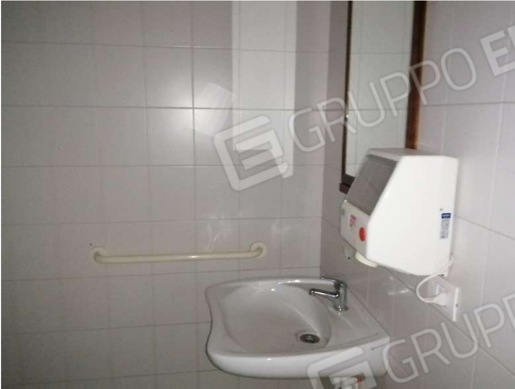
FO-95 PART. 159 FOGLIO 31 RIF. C – INTERNO – PIANO SECONDO LOCALI WC A SERVIZIO DELLA ATTIVITA' DI RISTORAZIONE
