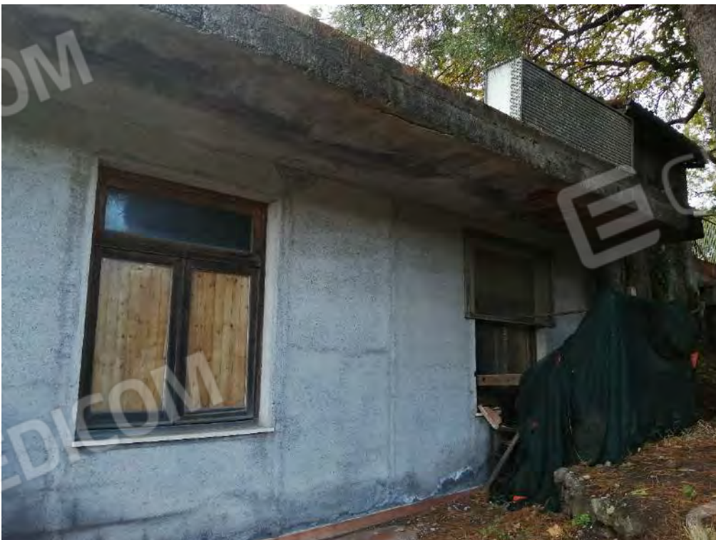
FO-50 PART. 159 FOGLIO 31 RIF. B – ESTERNO
