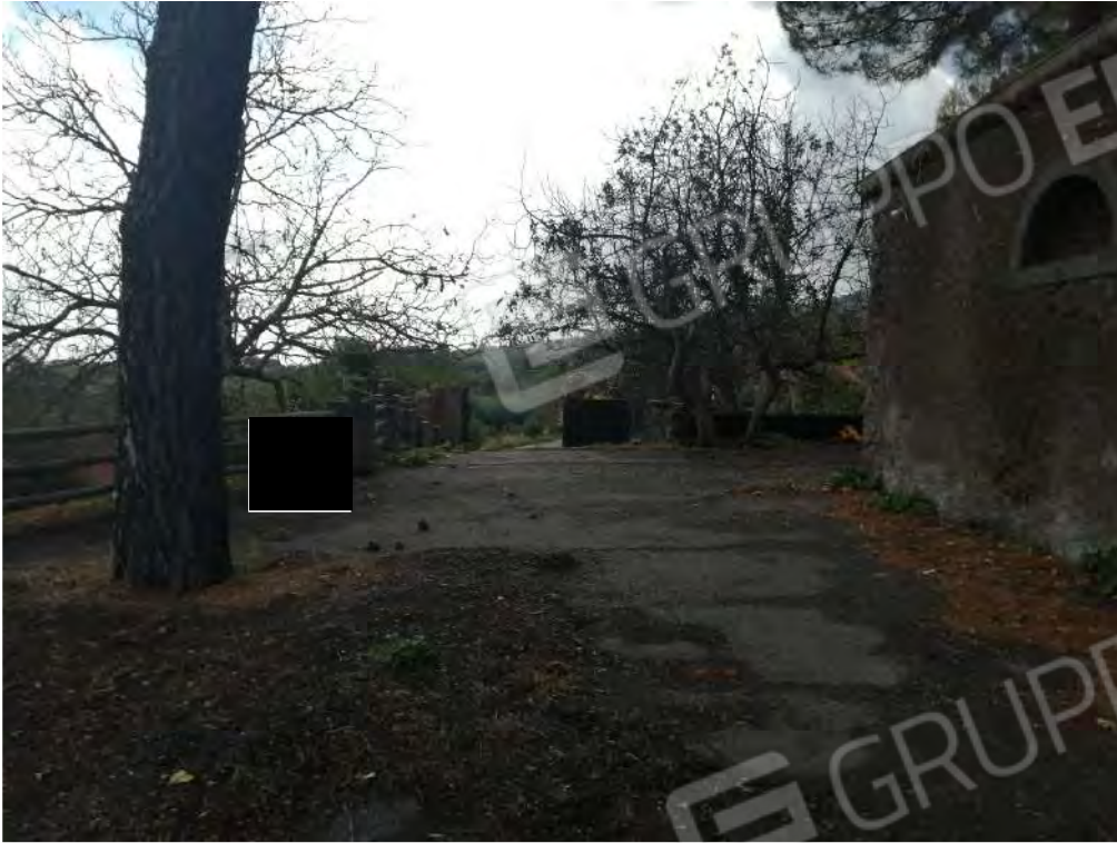
FO-75 PART. 159 FOGLIO 31 RIF. C – ESTERNO CANTINA -PIANO TERRA LATO EST
