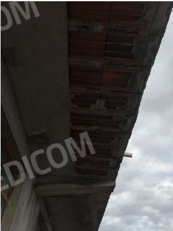
FO-54 PART. 159 FOGLIO 31 RIF. B – ESTERNO
