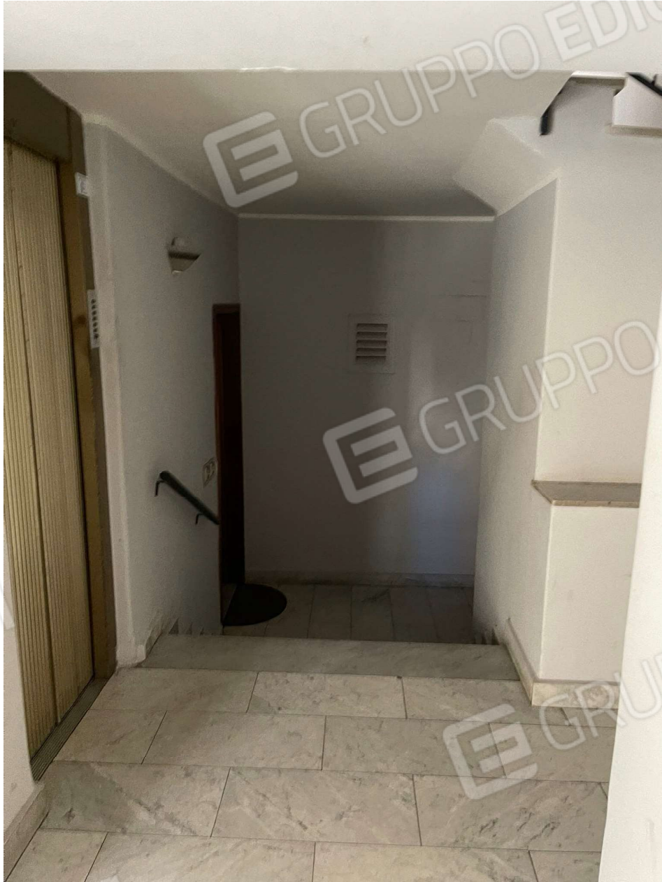
Foto 2 - Vista del vano scale condominiale4
