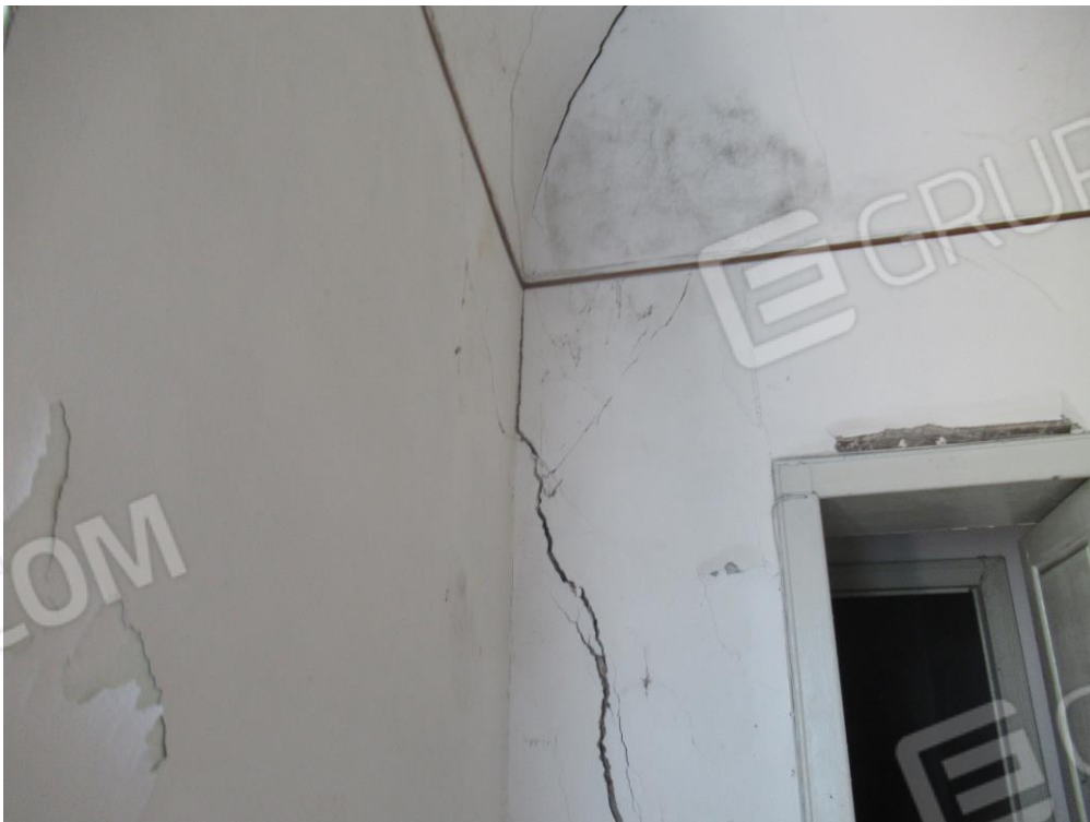
Foto n° 6 – Particolare delle pareti dell'immobile –
