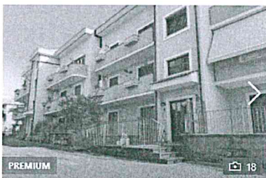
Bilocale via Giovanni Verga 23. Mascali
