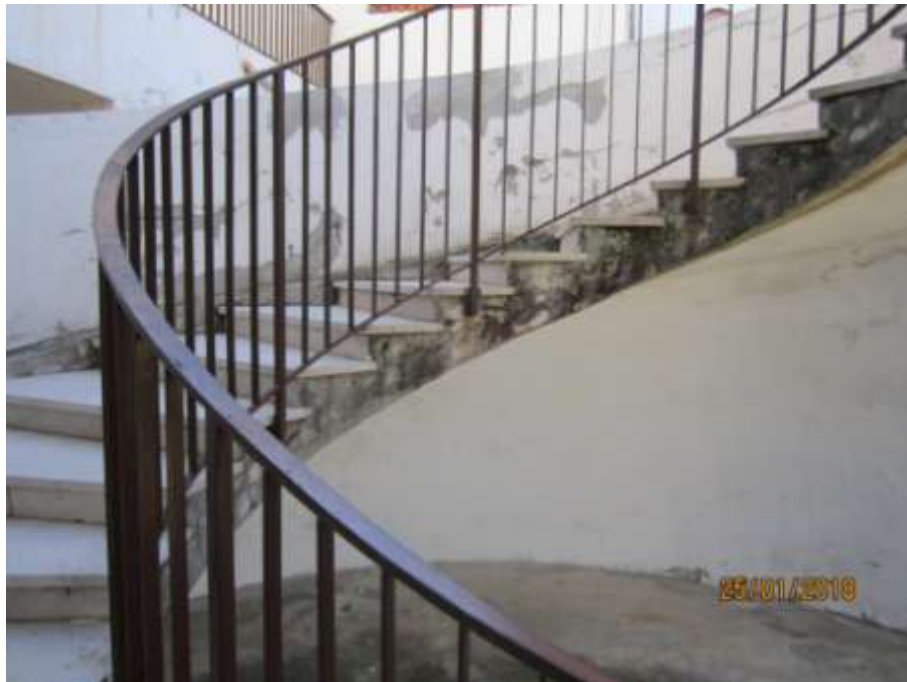
Foto n° 4 - La scala condominiale per il primo piano
