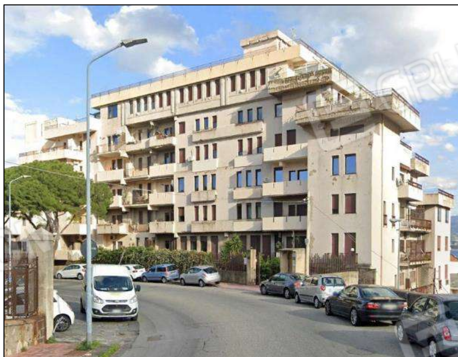
1.2. Vista Esterna dell'Immobile prospetto principale viale Regina Margherita
