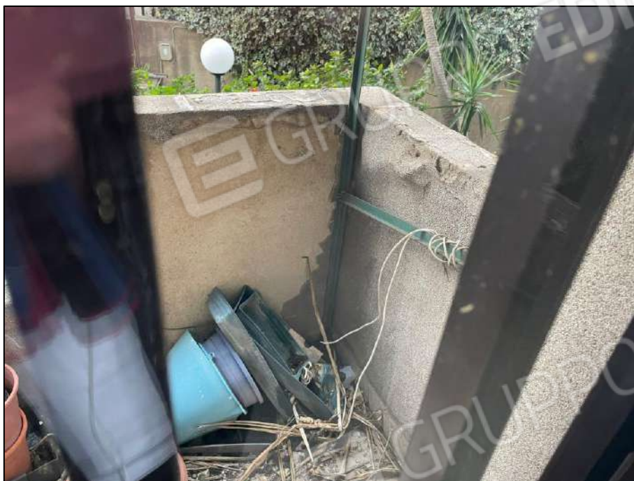
1.17. Particolare dello stato di manutenzione del balcone.
