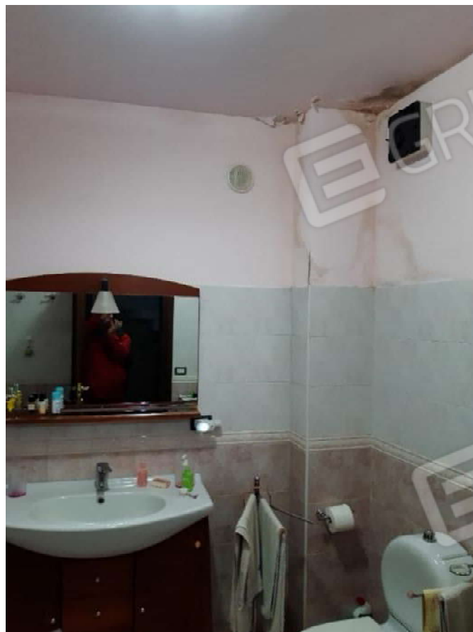
FOTO 14 – BAGNO – PIANO PRIMO
