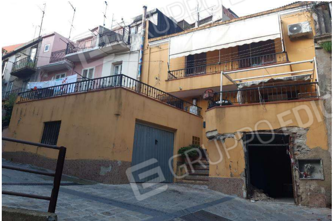
FOTO 1 – PROSPETTO SU VIA FULCI
