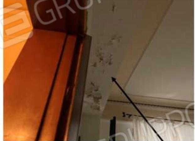
Fig. n. 15 Particolari delle macchie di umidità
