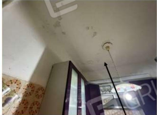
Fig. n. 17 Particolari delle macchie di umidità
