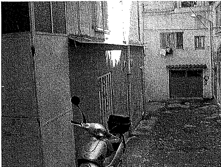
Vista prospetto fronte sud
