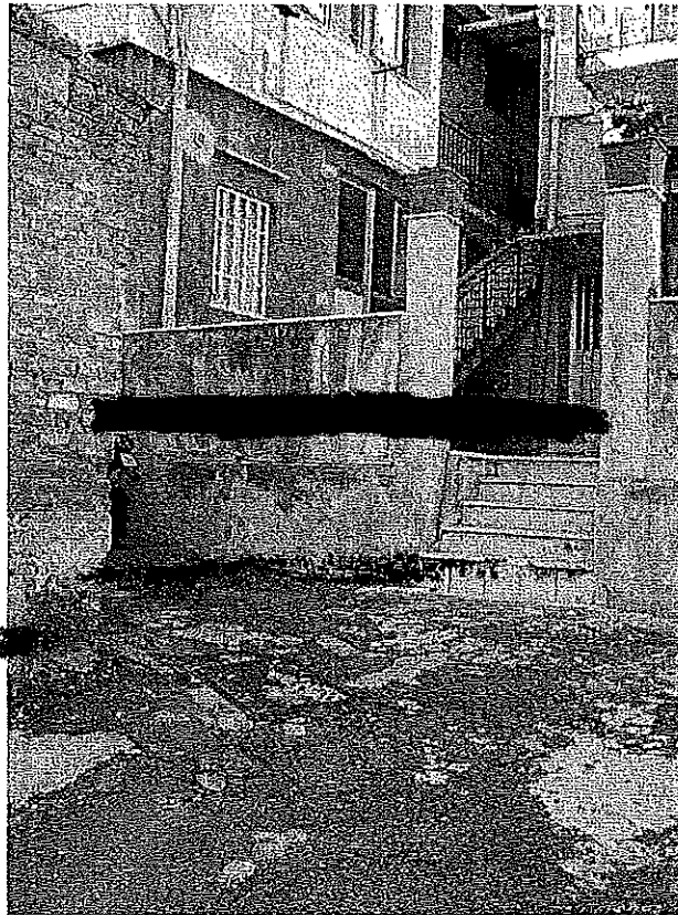
Vista accesso cortile condominiale
