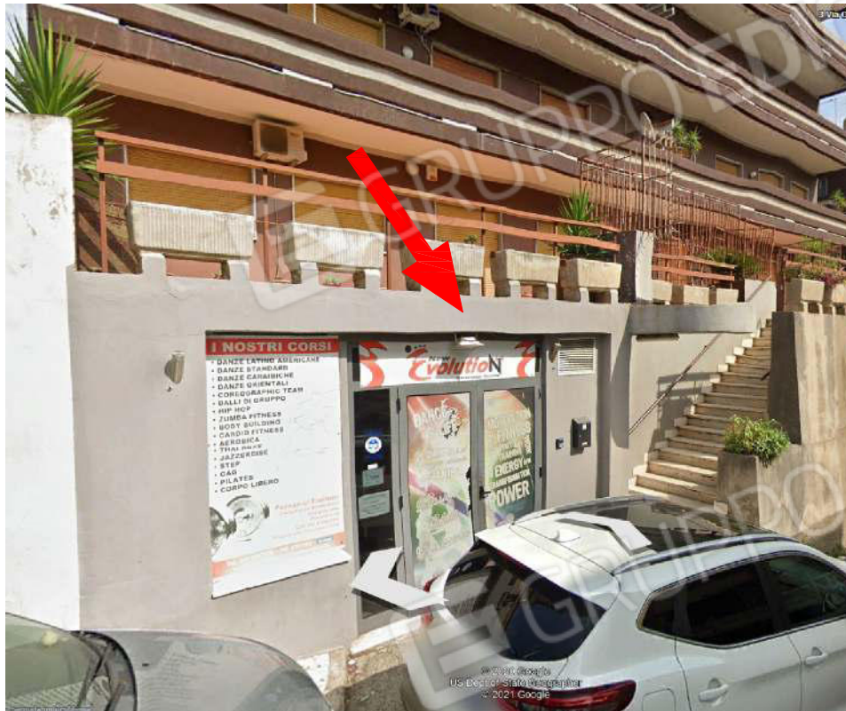
FOTO - Ingresso via Olimpica 4/a
