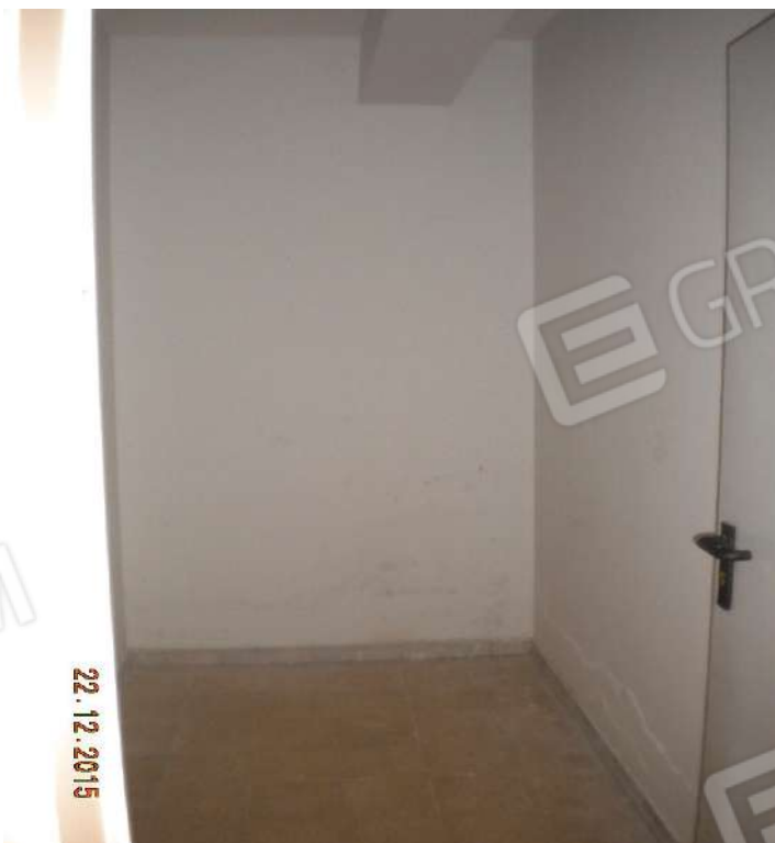
Foto 12 – Locale di Sgombero foglio 62 part. 1570 sub 17
