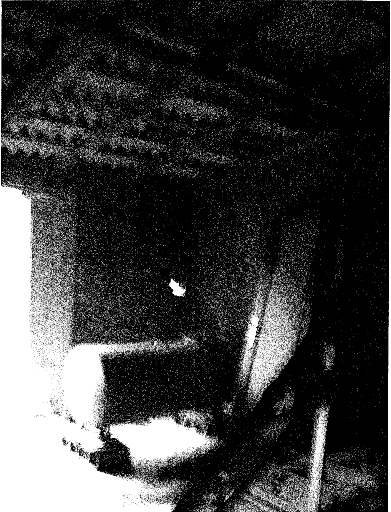
Copertura piano 2 in lastre di eternit
