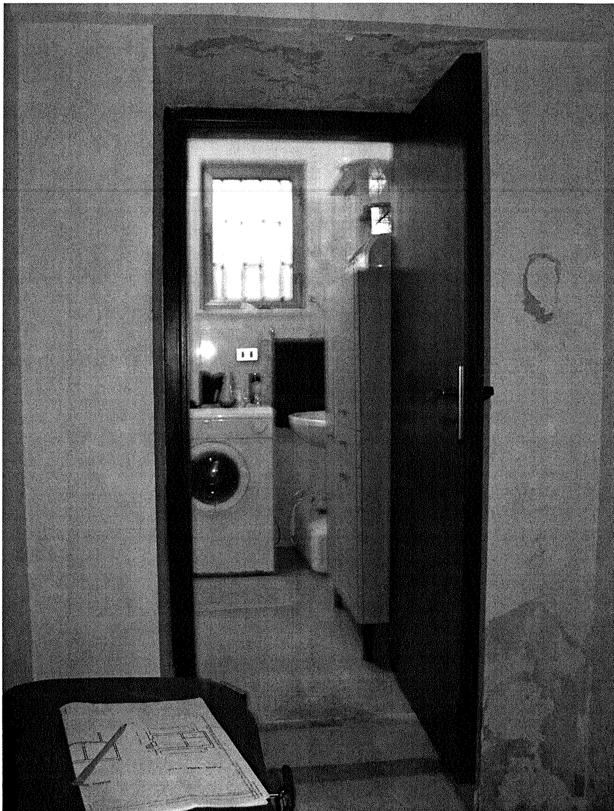
Bagno abusivo piano terra
