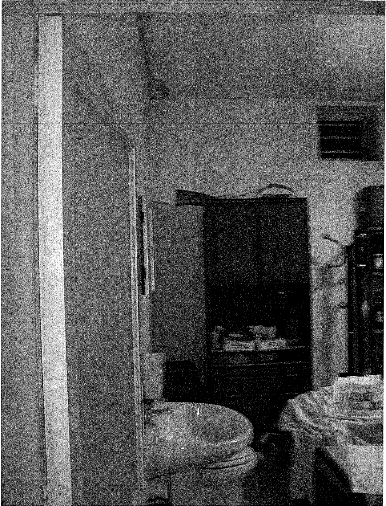
Secondo vano piano primo
