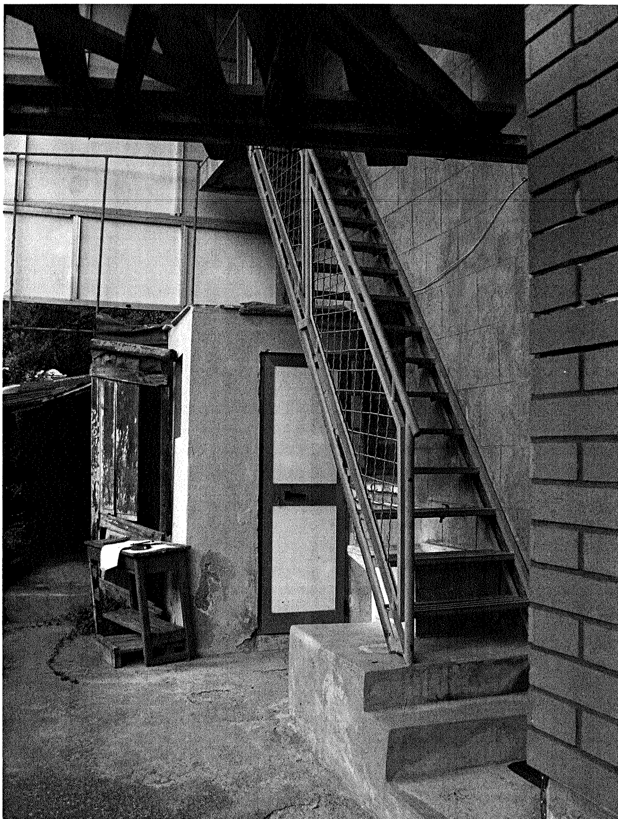
Scala per accedere al piano 1
