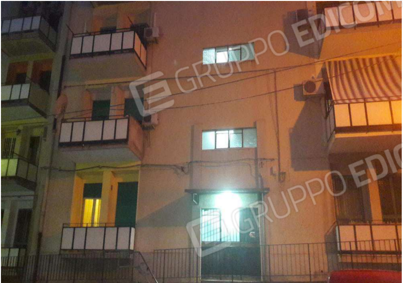
FOTO N.2 PORTONE CONDOMINIALE E PROSPETTO SULLA VIA 30/N.
