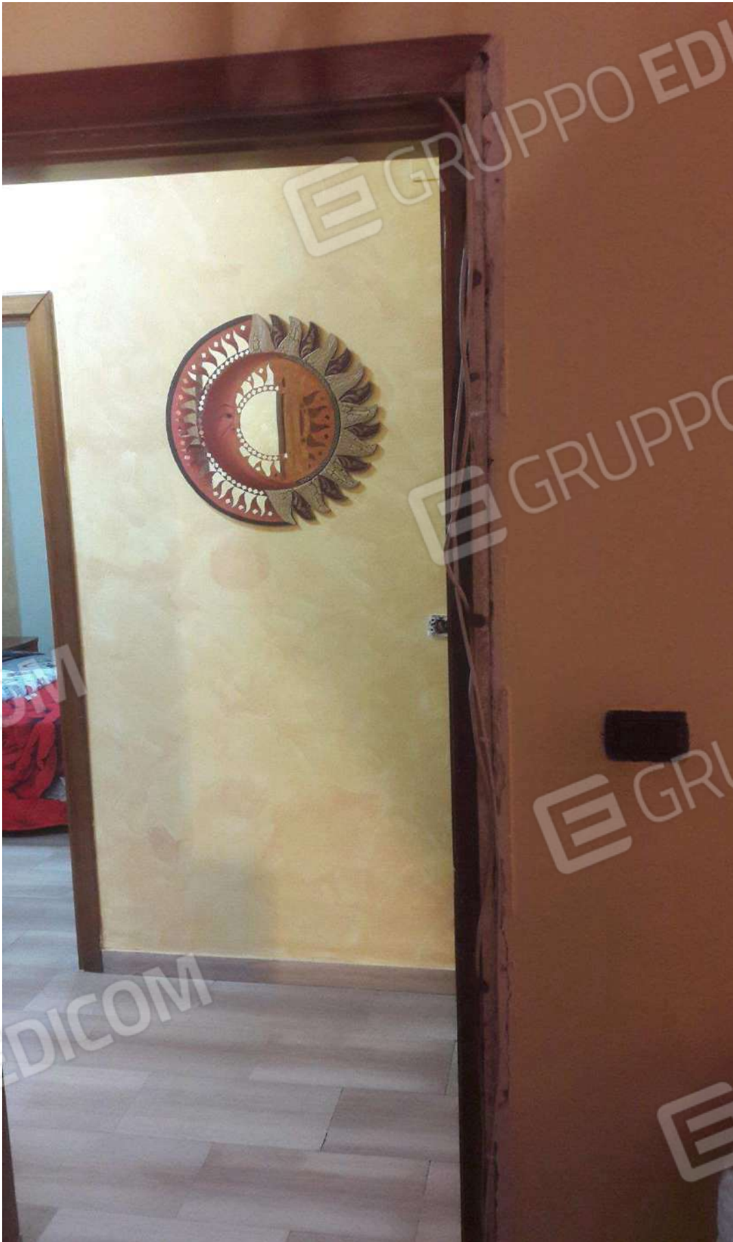
FOTO N.35 CORNICE INFISSO E PORZIONE DISIMPEGNO
