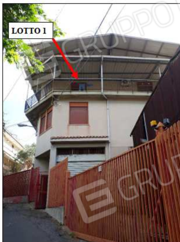
Foto 03: vista fabbricato da via Legname.
