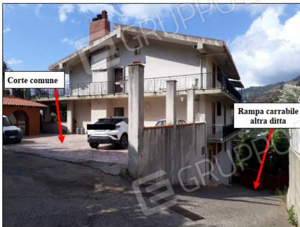
Foto 05: prospetto fabbricato lato nord-est.
