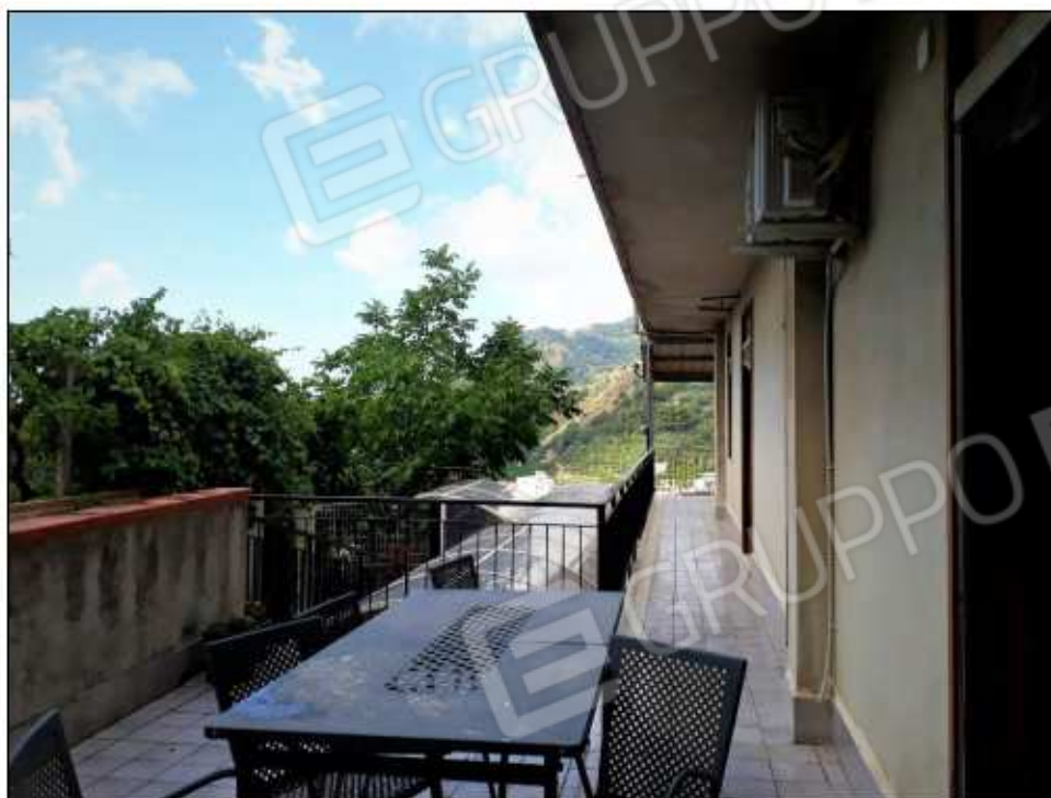
Foto 15: terrazzo e balcone lato sud-est.
