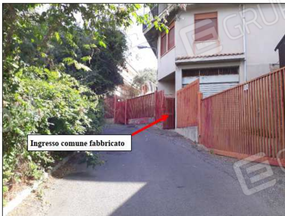
Foto 04: ingresso fabbricato sulla via Legname.
