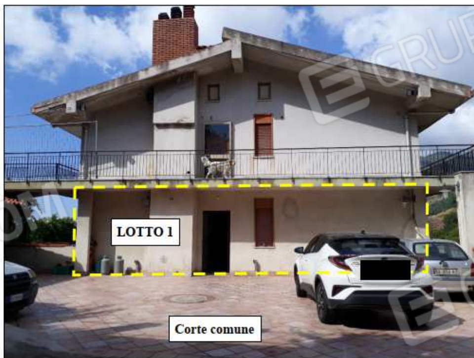
Foto 06: prospetto fabbricato lato nord-est.
