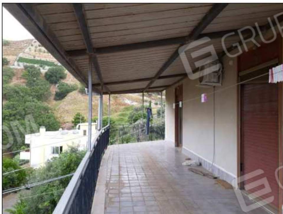
Foto 16: balcone lato sud-ovest.
