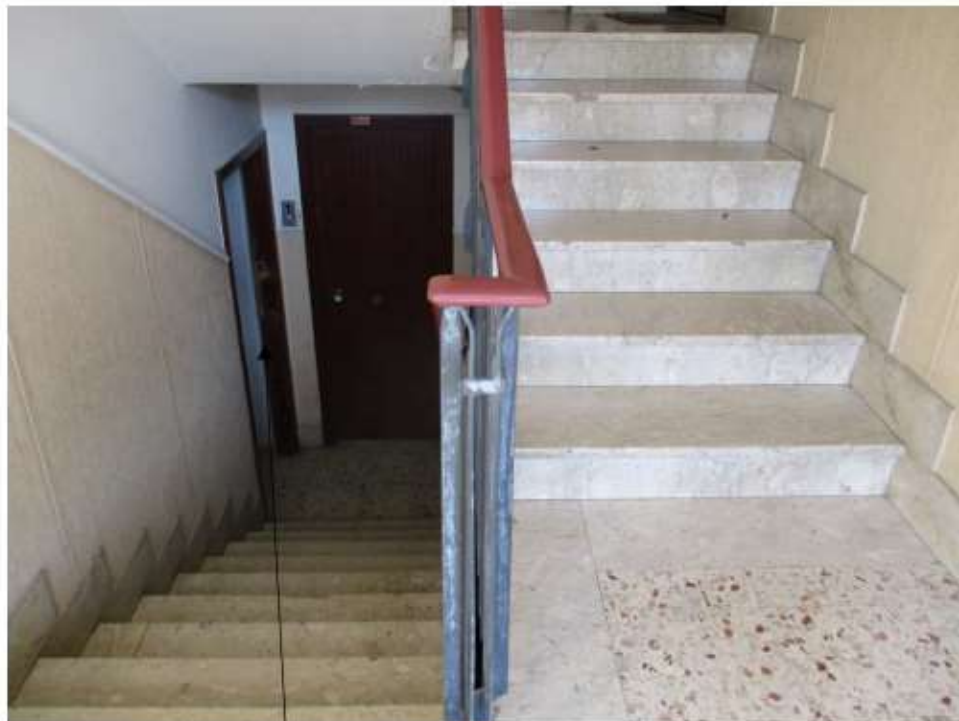
Accesso alle cantine Foto n. 14
