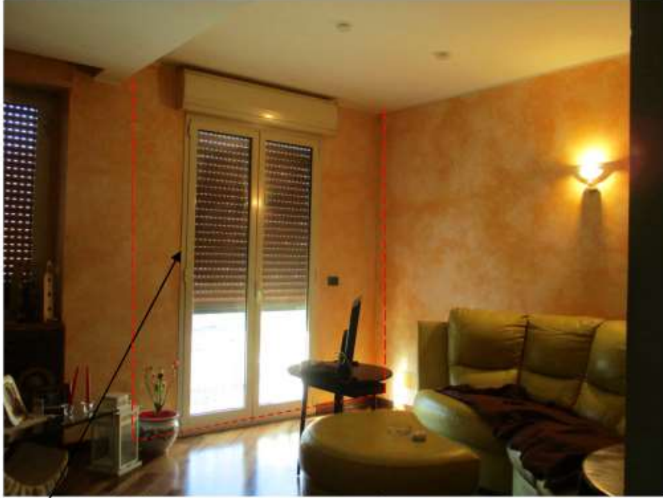
Parete da demolire e ricostruire come da progetto Foto n. 9 - Soggiorno
