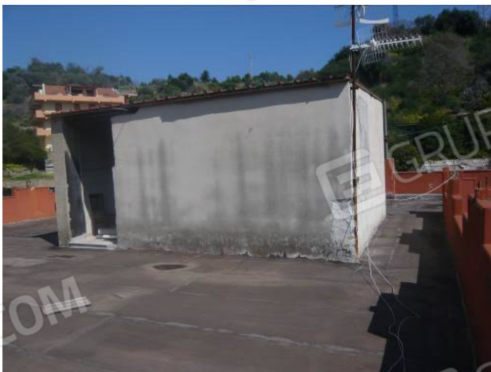
FOTO 51 – LASTRICO SOLARE CON LOCALE DEPOSITO
