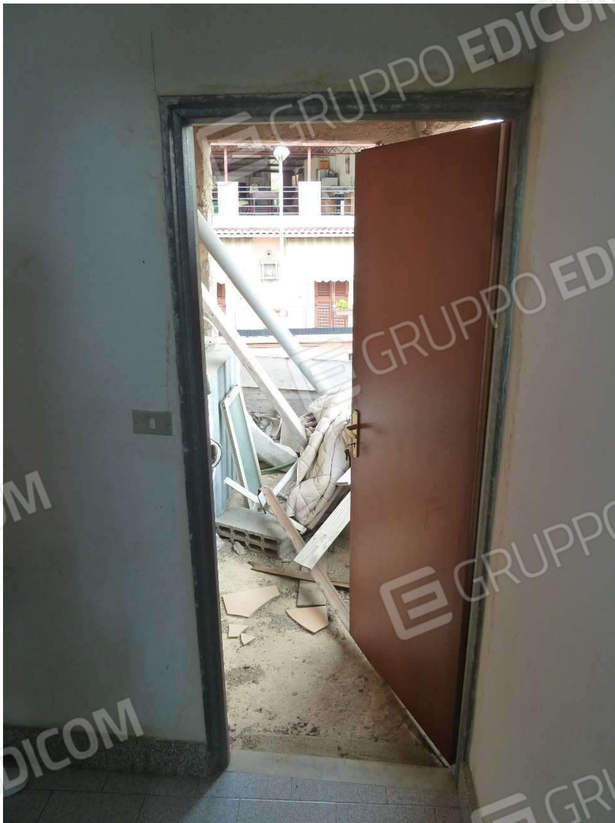
Ingresso locale deposito, vista dal pianerottolo d'ingresso.
