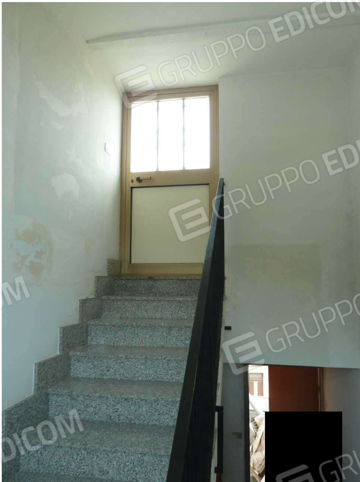
Vista dal pianerottolo del locale deposito, particolare accesso a piano copertura.
