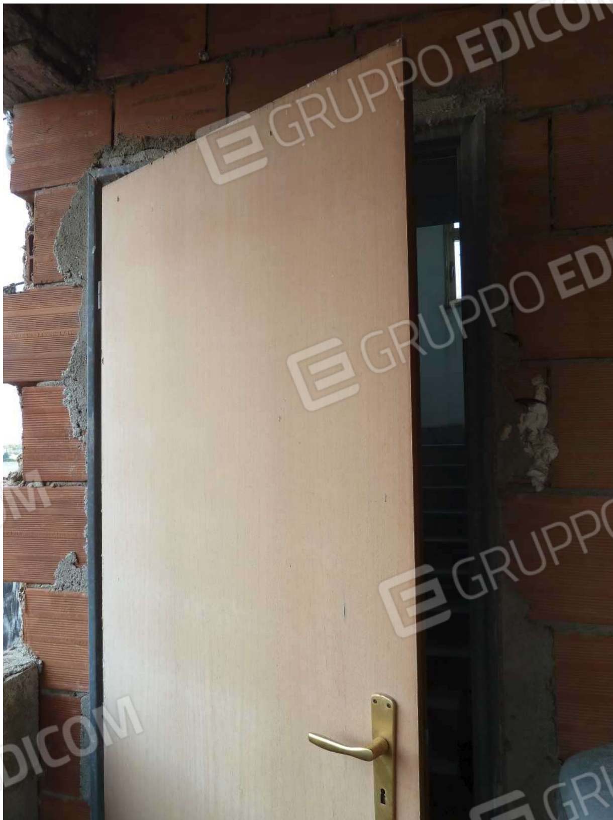
Ingresso locale deposito, vista dall'interno.
