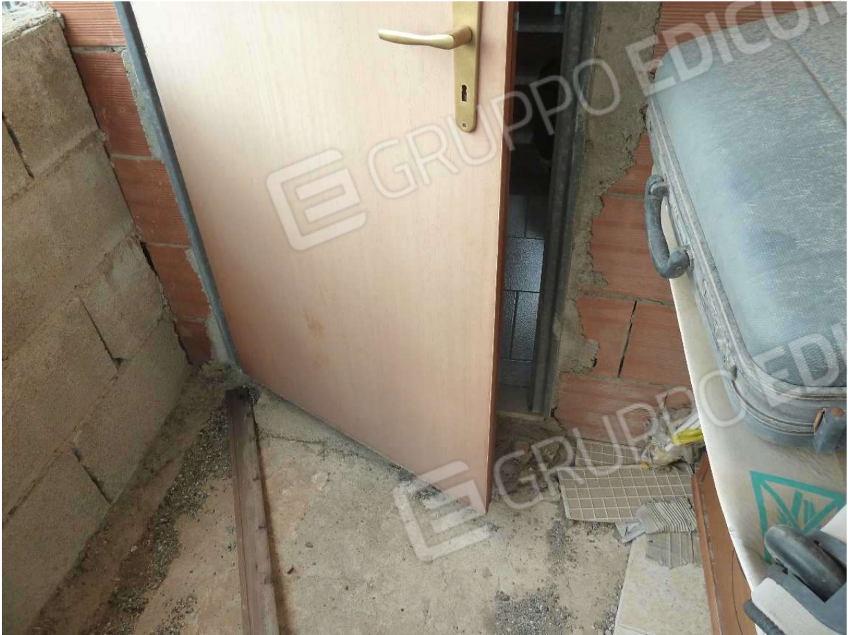
Locale deposito, particolare.
