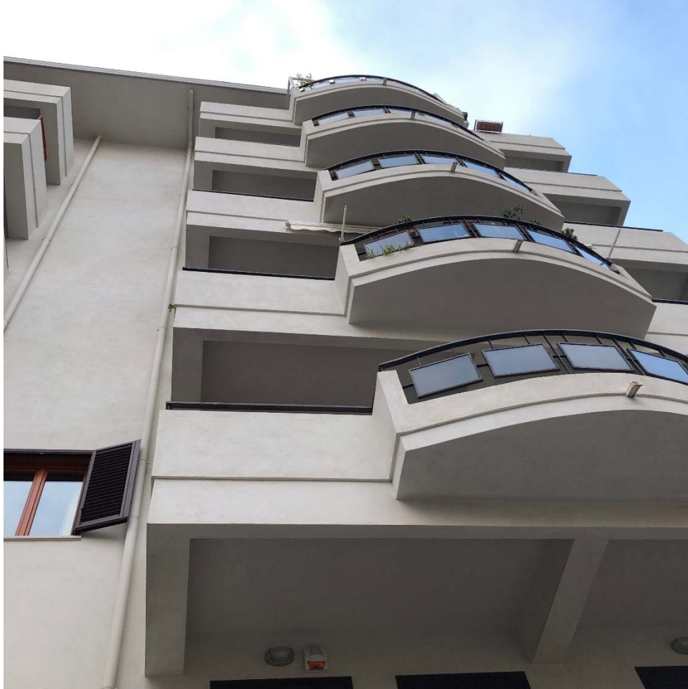
20) PARTICOLARE INTRADOSSO BALCONI PROSP. NORD
