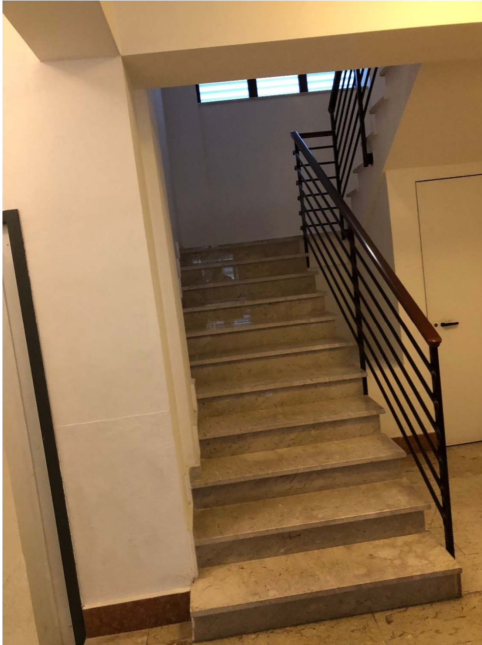
18 ) PRIMA RAMPA SCALA CONDOMINIALE AL PIANO TERRA
