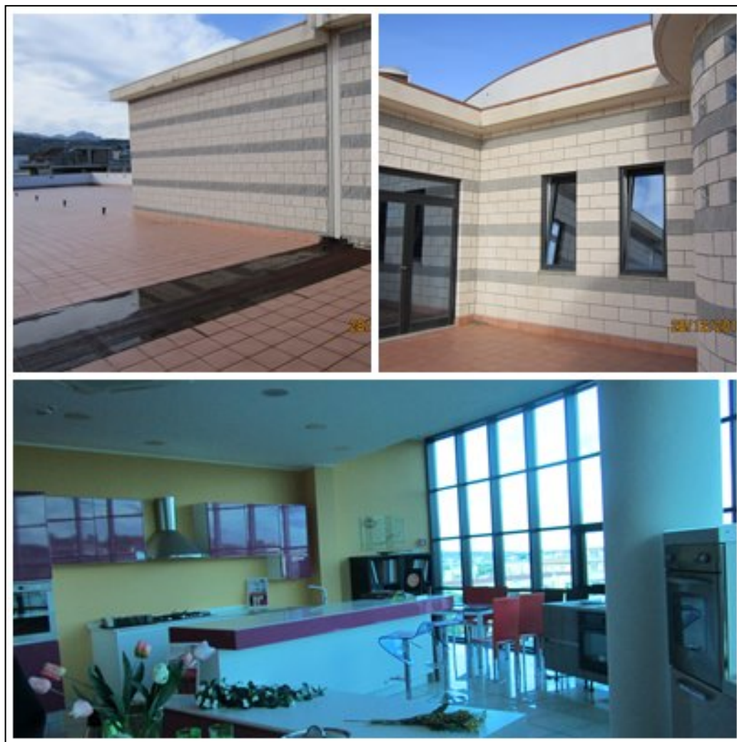
Foto 5 – In alto le terrazze, in basso l'interno
