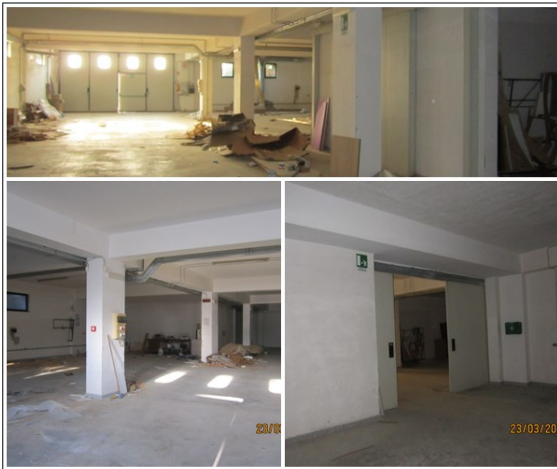
Foto 2 – L'entrata, l'ambiente interno, la porta di separazione dal Lotto 1
