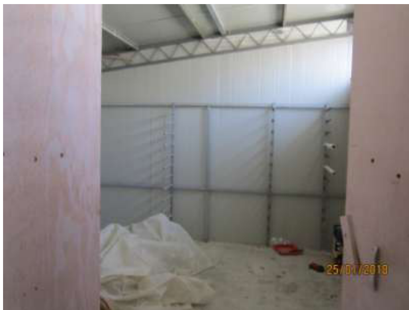
Foto n° 38 Locale asciugatura limitrofo
