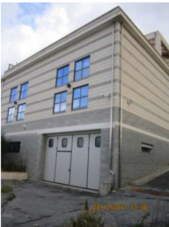
Foto n° 4 Facciata lato ovest con entrata merci piano seminterrato e finestre piano terra
