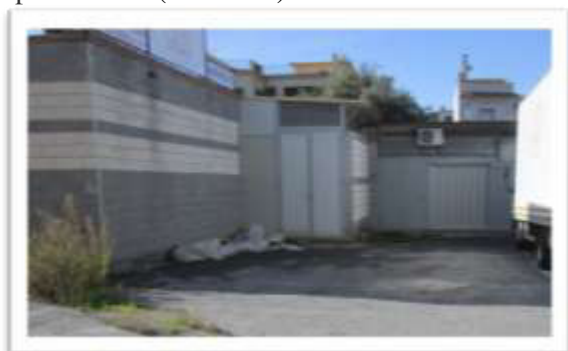
Vista esterna dei locali
