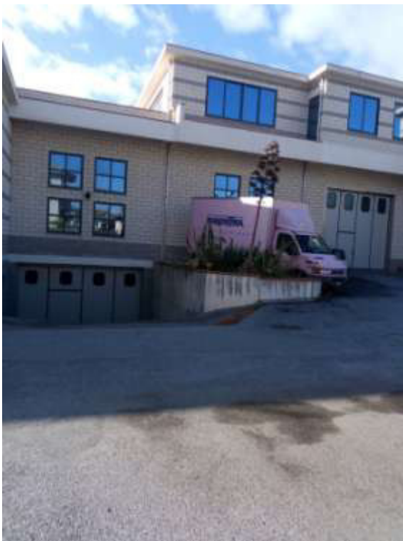
Foto n° 3 Facciata lato est con entrata merci piano terra e rampa d'entrata piano seminterrato
