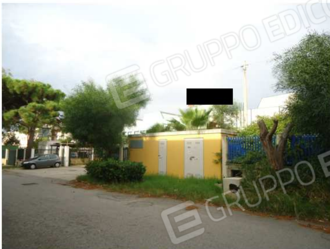
FOTO n. 29: Cabina elettrica mt/bt
